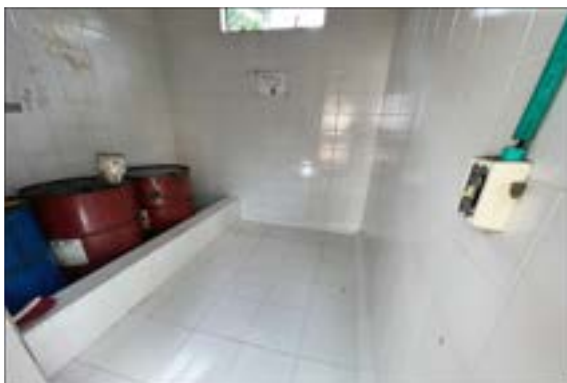
Figura 35. Cuarto de residuos peligrosos después del protocolo de aseo
