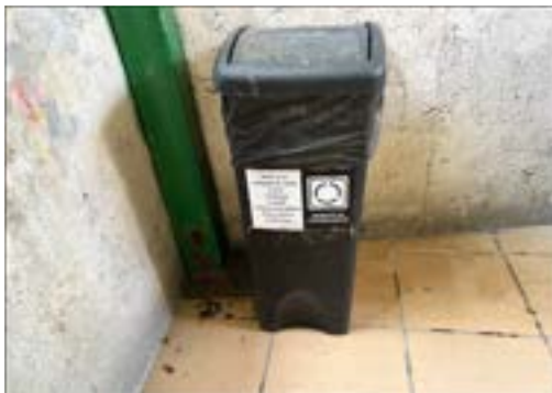
Figura 12. Adecuación del recipiente de disposición de residuos en la zona de lavado de dotación
