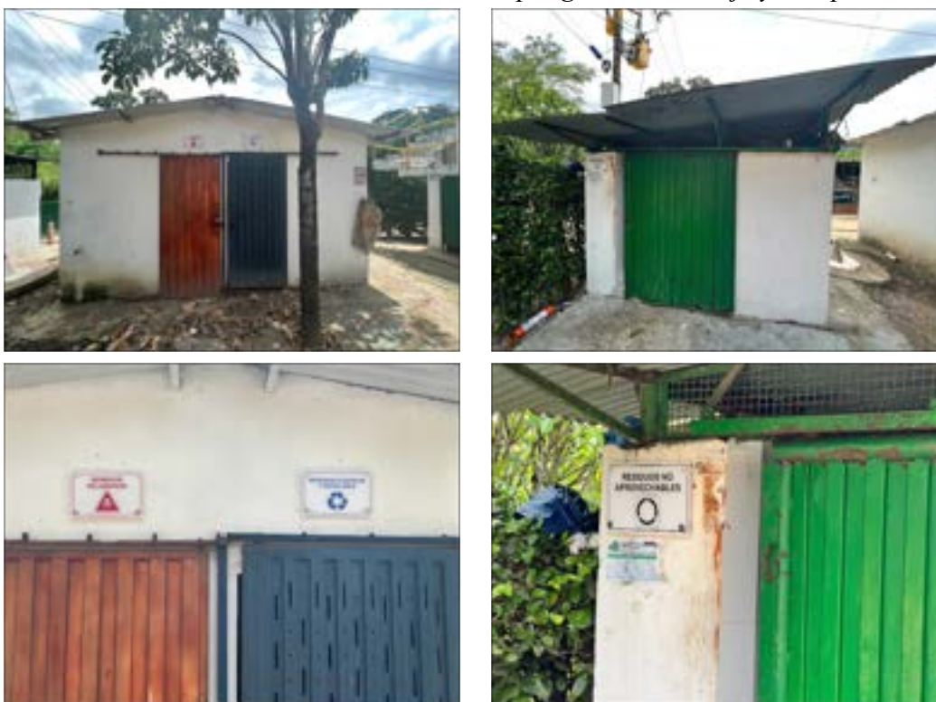
Figura 30. Cuartos de almacenamiento de residuos peligrosos, reciclaje y no aprovechables
