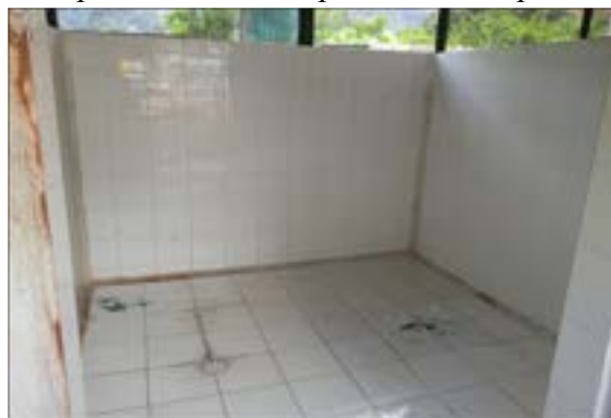
Figura 39. Cuarto de residuos no aprovechables después de su limpieza
