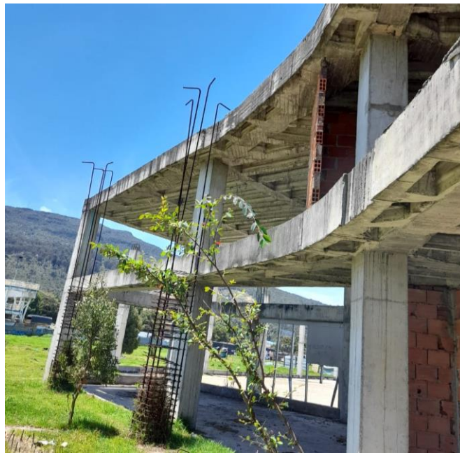
Ilustración 6. Estado actual de la estructura.
