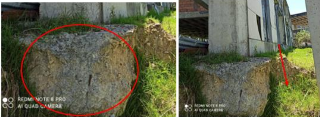
Ilustración 7. Porción de la cimentación visible (zapata).
