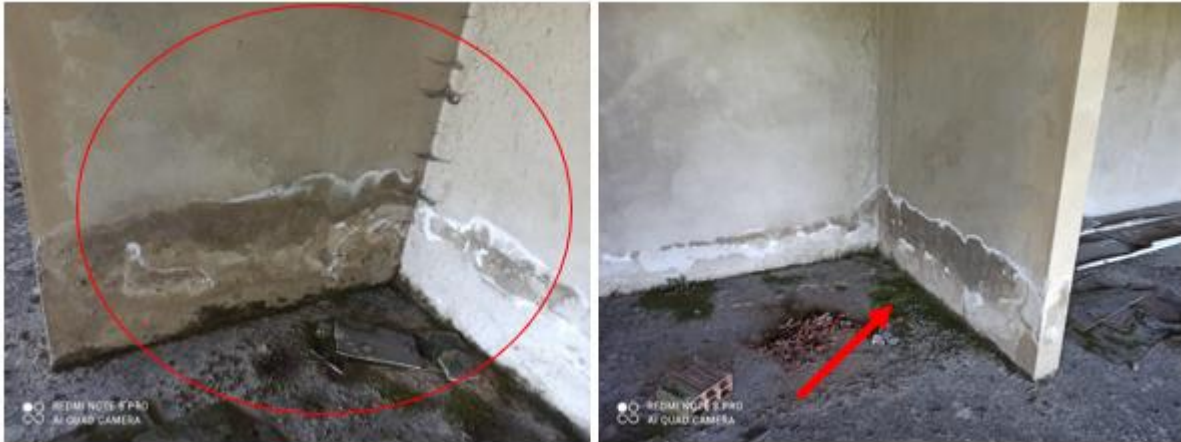
Ilustración 14. Muros de confinamiento
