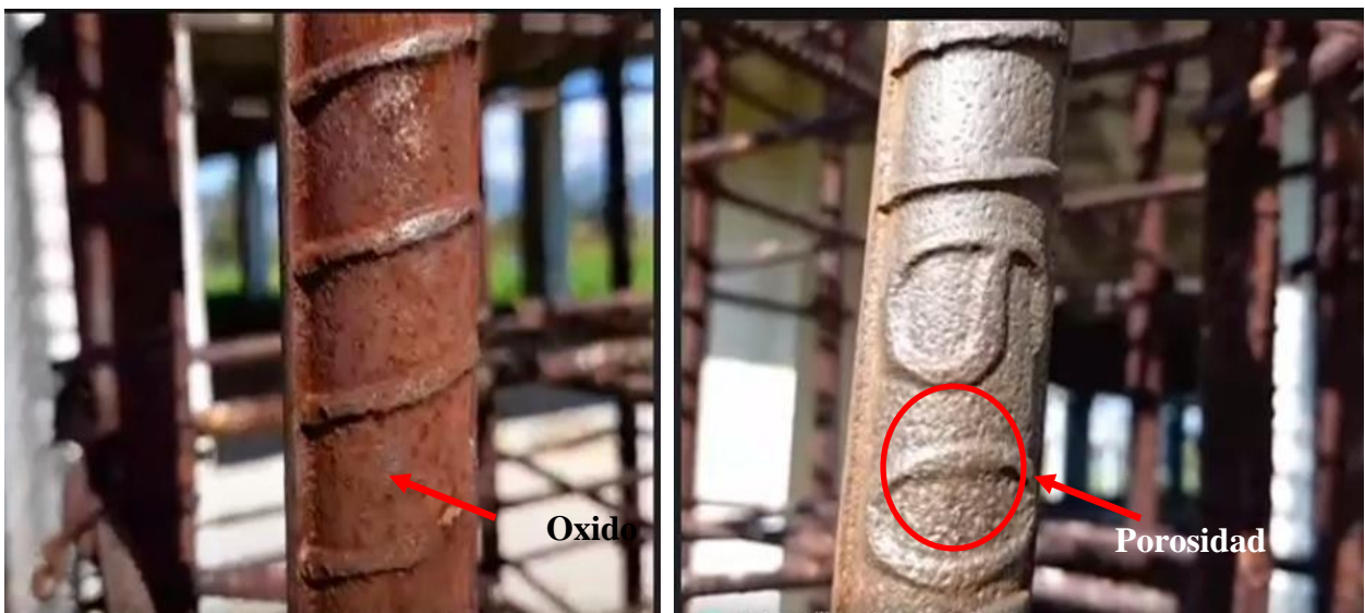
Ilustración 23. Elemento oxidado (izq.) y elemento final al cepillado (der.)
