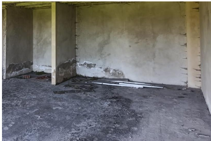
Ilustración 16. Placa de concreto piso superior
