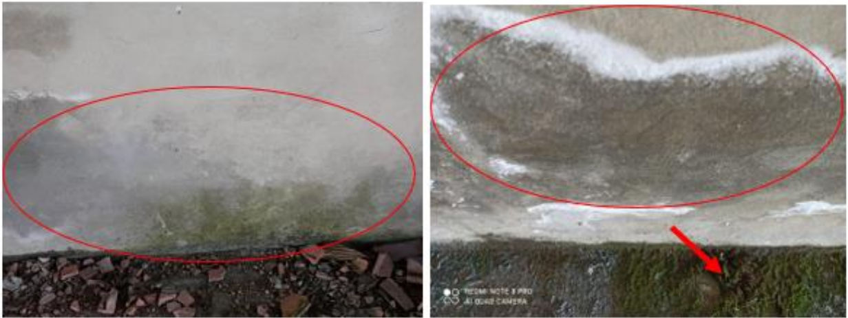
Ilustración 15. Zona inferior de los muros de confinamiento
