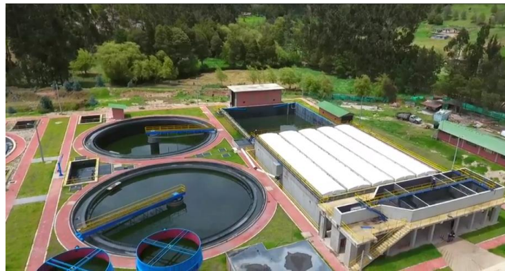
Img.14 Fotografía que muestra desde un plano alto parte de la planta Fuente: Video PTAR de Veolia
