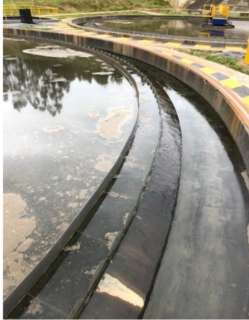
Img.33 Canales del tanque sedimentador y el sistema de limpieza que utilizan cuando los operarios no lo limpian. Fuente: Autores
