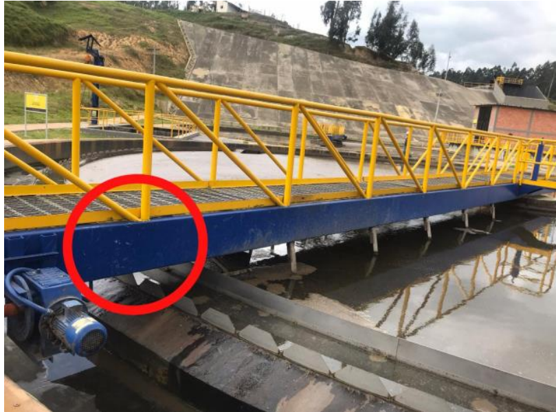
Img.46 Ubicación para las lámparas tipo tortuga en el barrelos. Fuente: Autores
