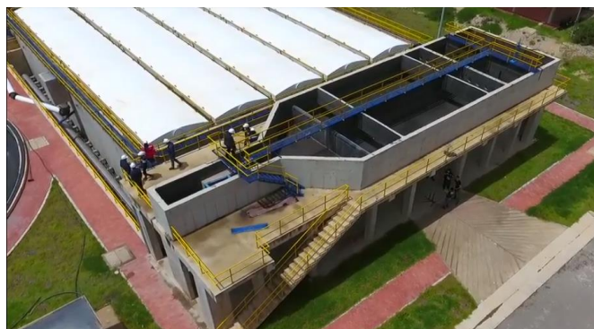
Img. 7 Vista real del desarenador. Fuente: Video PTAR de Veolia
