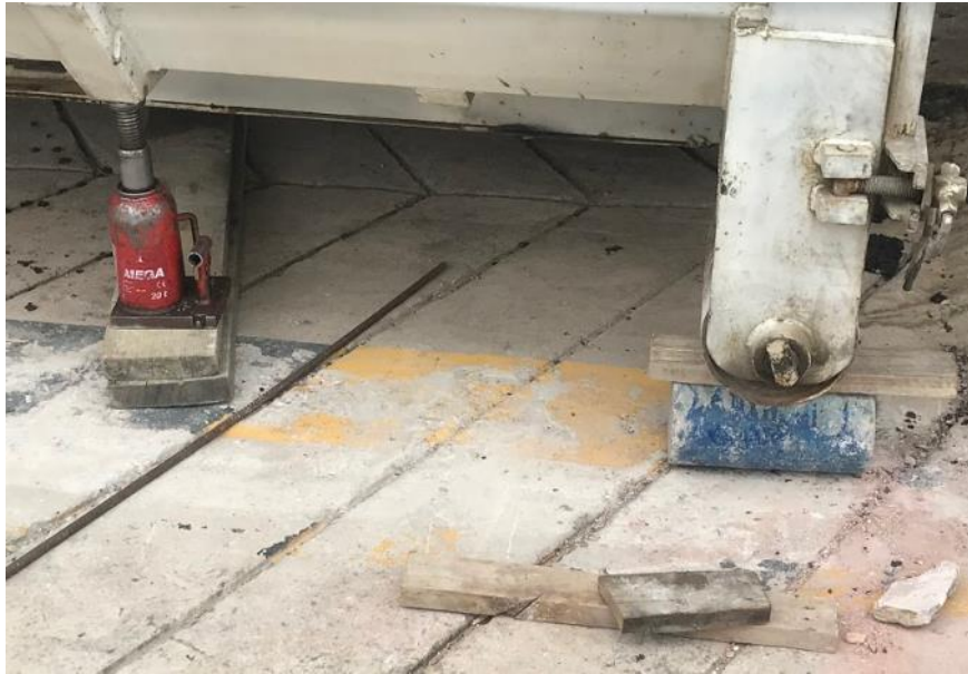
Img.51 Sistema de elevación hecho por los operarios. Fuente: Autores
