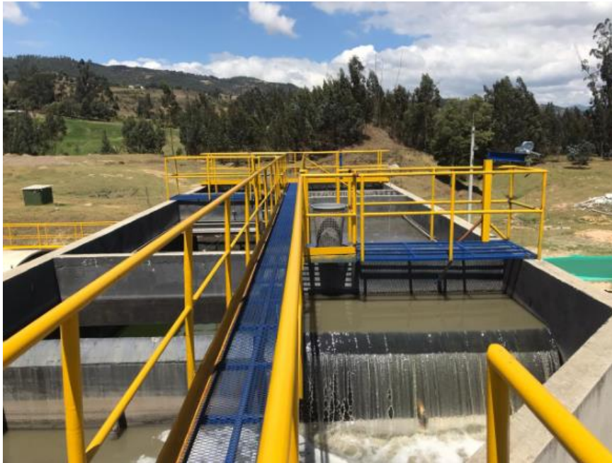
Img.18 Vista principal de los tanques desarenadores del módulo 3. Fuente: Autores
