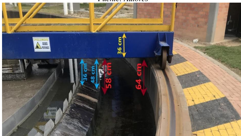
Img.37 Medidas tomadas del módulo 3 en el sedimentador 1. Fuente: Autores
