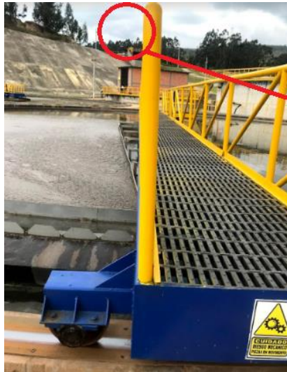
Img. 48 Ubicación de la lámpara con la base que debe ir soldada a la punta del barrelos. Fuente: Autores
