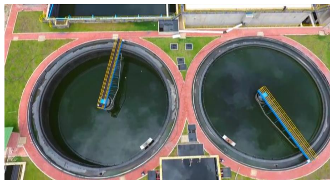
Img. 11 Vista Real de los tanques sedimentadores.
