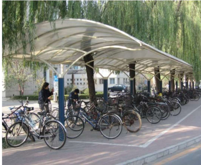
Imagen 11 Estacionamiento con instalación de cobertura en Beijing.
