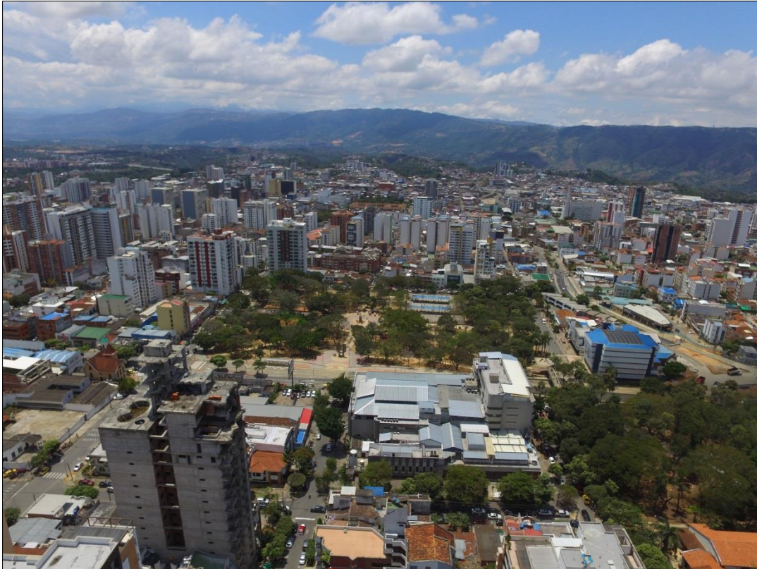
Figura 47 Toma Aérea Sector de San Alonso, Bucaramanga Santander
