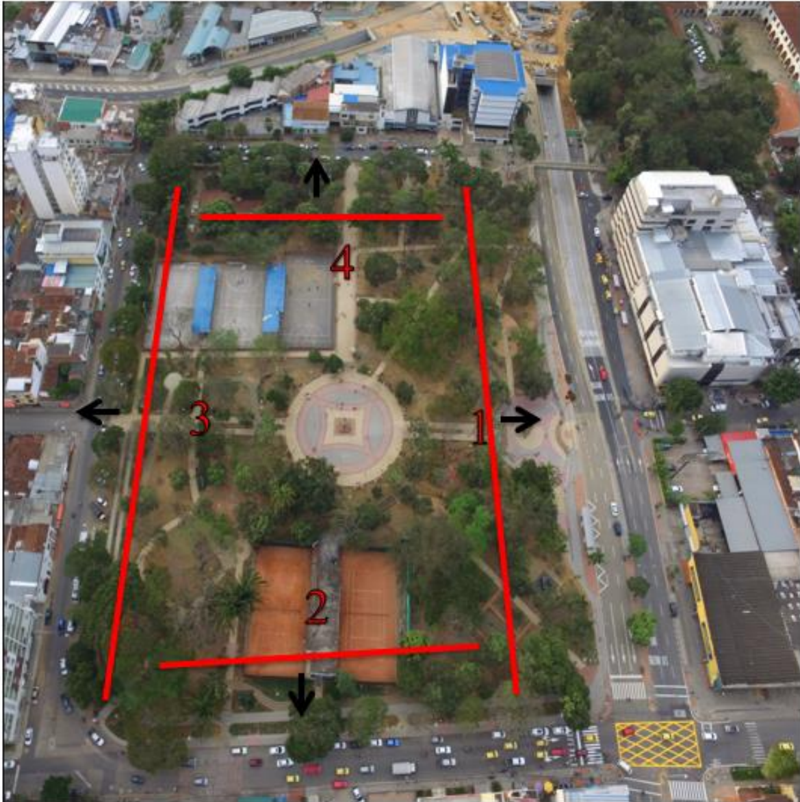
Figura 55 Toma Aérea Sector de San Alonso, Bucaramanga Santander
