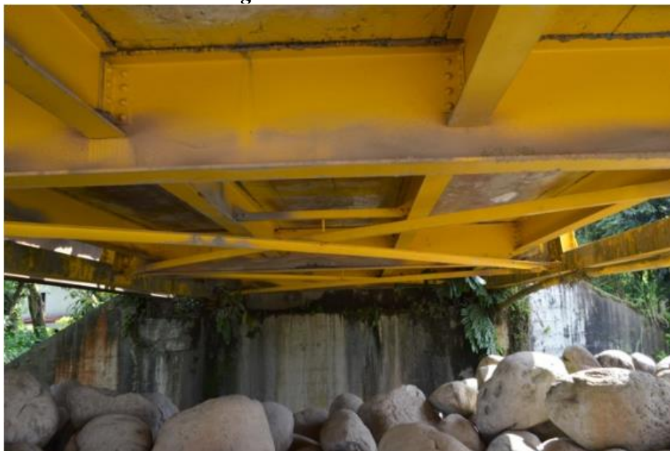
Figura 8 Vista estribo sur
