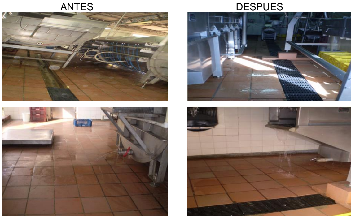
Figura 18. Uso de rejillas en las canales y cajas donde atraviesan las agua residuales
