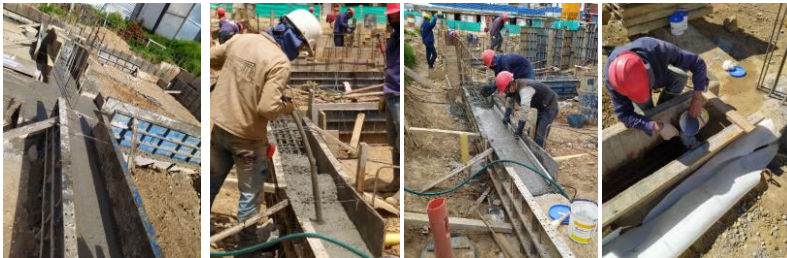
Ilustración 11: Fundida de dados y vigas de cimentación
