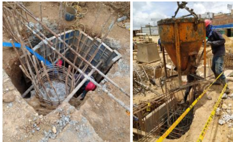
Ilustración 13: Demolición y reparación de pilotes.
