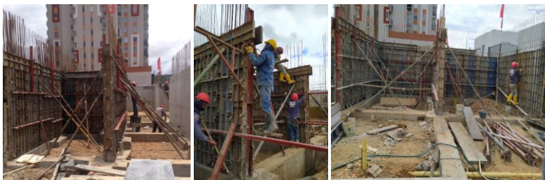
Ilustración 17: Encofrado de secciones
