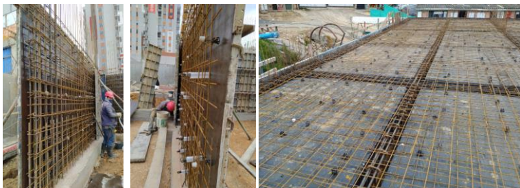
Ilustración 20: Instalación de distanciadores.
