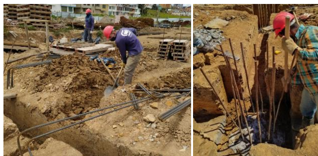
Ilustración 3: Excavación manual de vigas y dados de cimentación.
