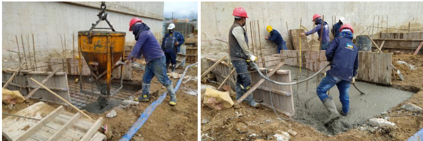
Ilustración 25: Fundida de elementos cimentación plazoleta 3.
