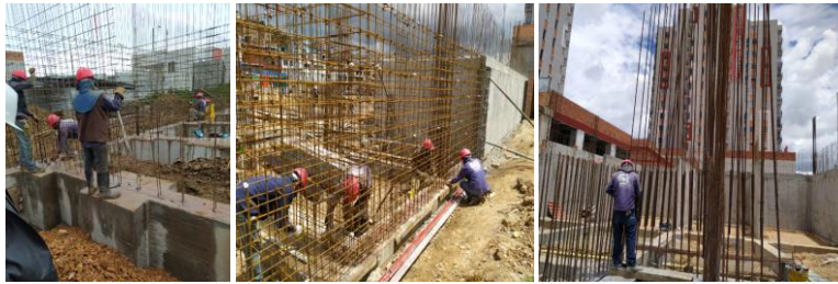
Ilustración 16: Instalación de refuerzo de muros
