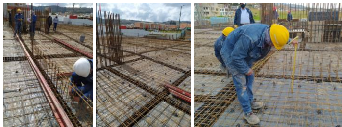
Ilustración 30: Refuerzo en elementos de entrepiso.
