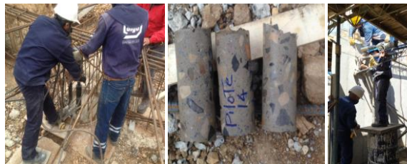
Ilustración 5: Extracción de núcleos de concreto.
