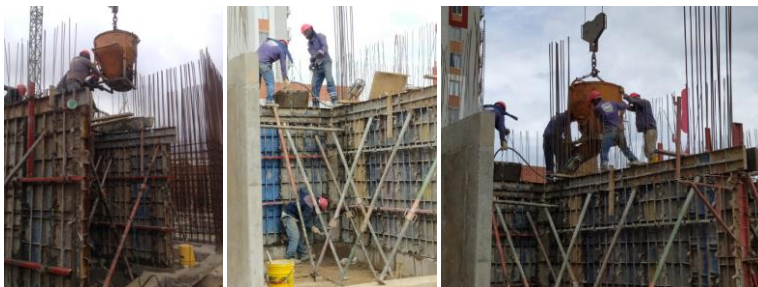
Ilustración 19: Fundida de muros.
