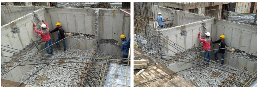
Ilustración 33: Demolición de elementos estructurales.
