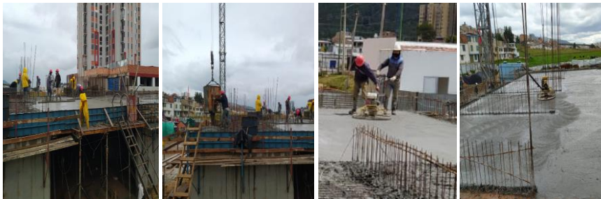
Ilustración 32: Fundida de elementos de entepiso N-3.65.
