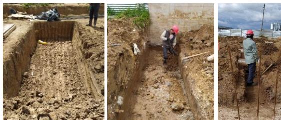
Ilustración 18: Excavación cimentación plazoleta 3.
