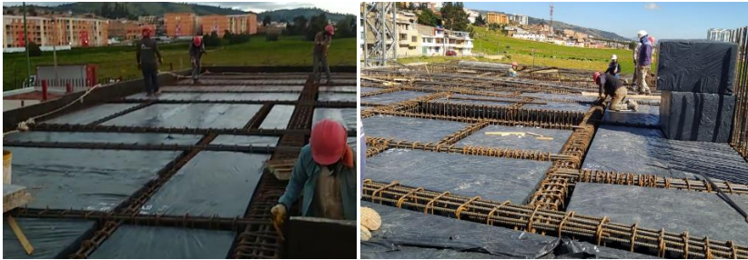
Ilustración 31: Instalación de casetón.
