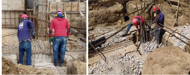
Ilustración 7: Descabece de pilotes
