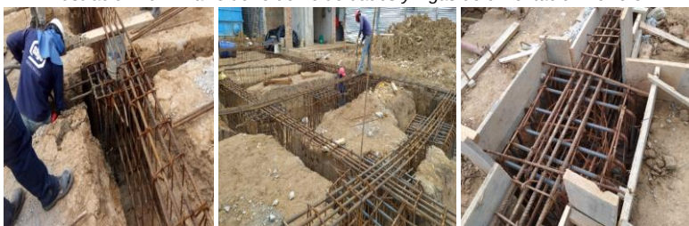
Ilustración 10: Amarre de refuerzo de dados y vigas de cimentación Torre 3
