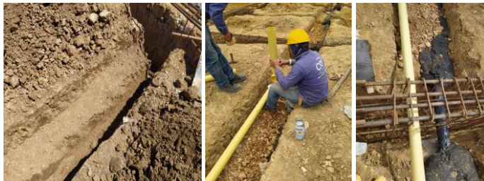
Ilustración 15: Instalación de sistema de drenaje.
