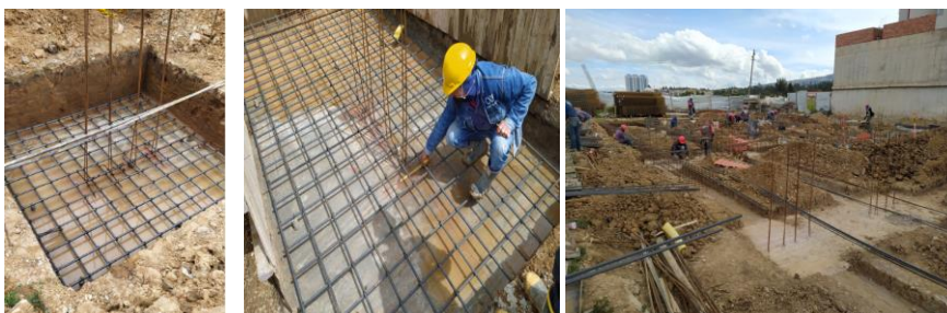
Ilustración 23: Amarre de refuerzo cimentación plazoleta 3.
