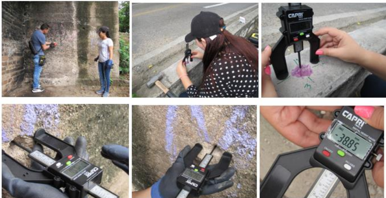
Figura 35. Evidencias ensayo de carbonatación.
