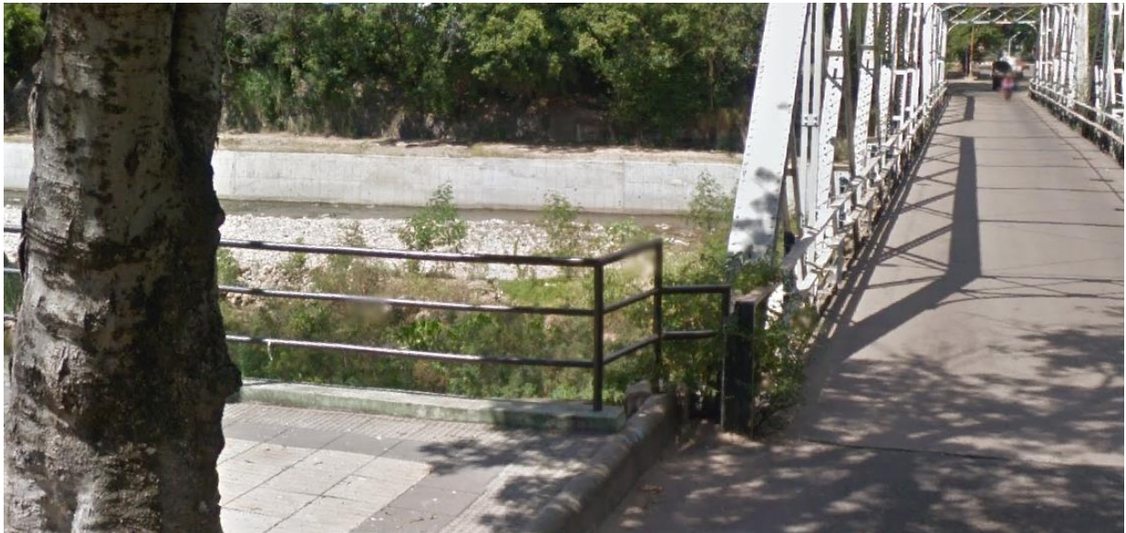
Figura 12. Canalización río Las Ceibas desde el puente Centenario. Fuente propia
