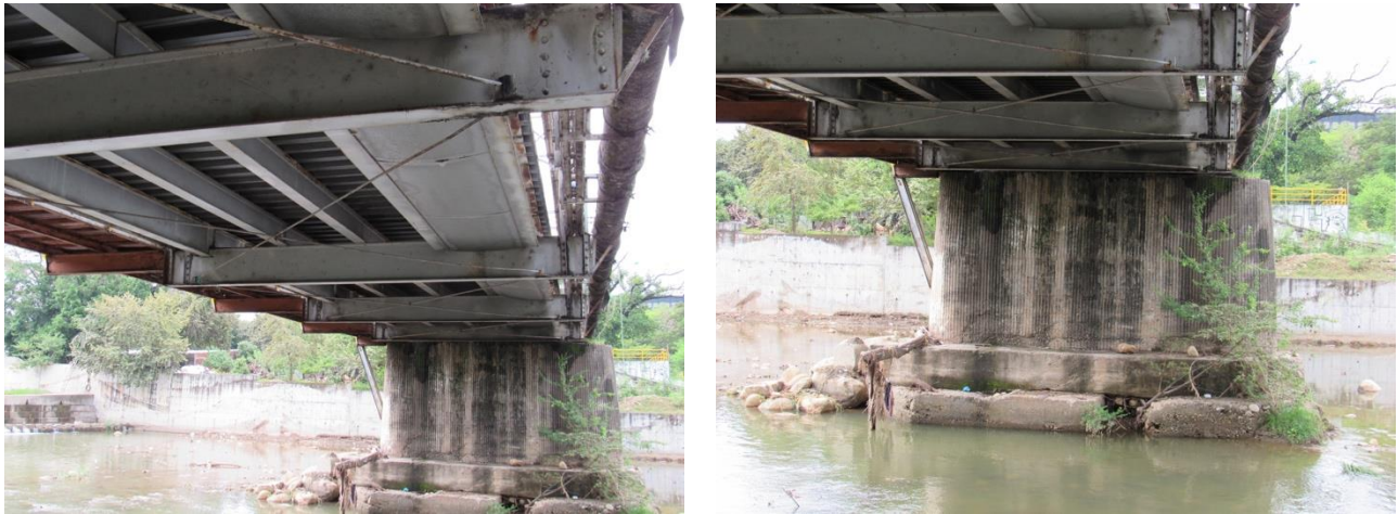
Figura 47. Imagen de estribos socavados del paciente.
