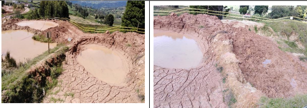
Imagen No 48 y 49. Infraestructura del lavadero de arenas
