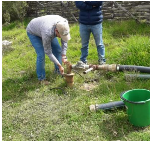
Imagen 17. Prueba de bombeo volumétrico
