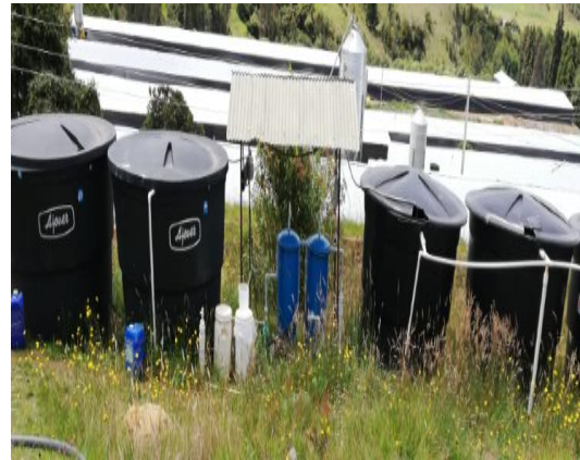
Imagen No 28 y 29. Sistema séptico y PTAR
