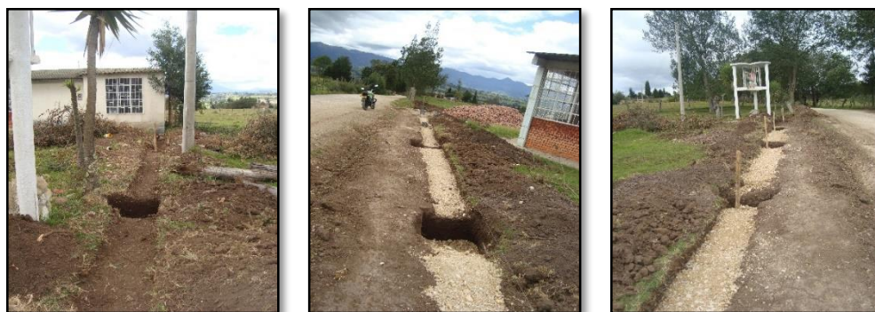
Figura 7: Excavaciones manuales para vigas de amarre.
