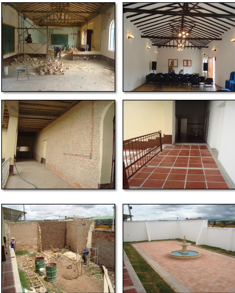
Figura 42. Antes y después remodelación Casona.
