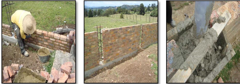
Figura 12. Construcción del muro en mampostería confinada.
