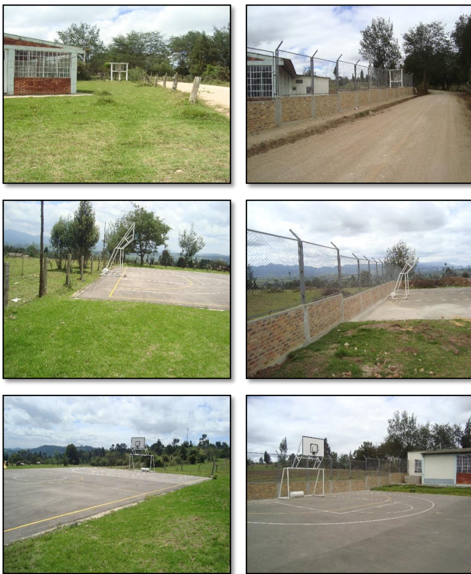
Figura 39. Antes y después construcción del cerramiento.
