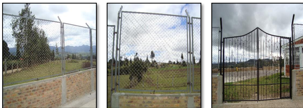
Figura 13. Instalación de malla eslabonada y portón.
