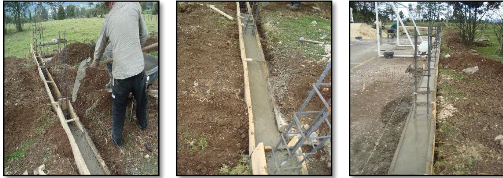
Figura 11: Elaboración de vigas en concreto 3000 PSI.
