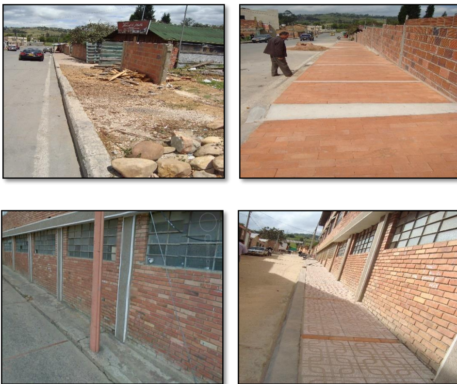
Figura 40. Antes y después construcción de andenes
