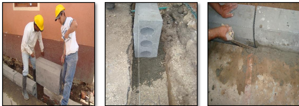
Figura 29. Instalación en sitio de bordillos prefabricados.
