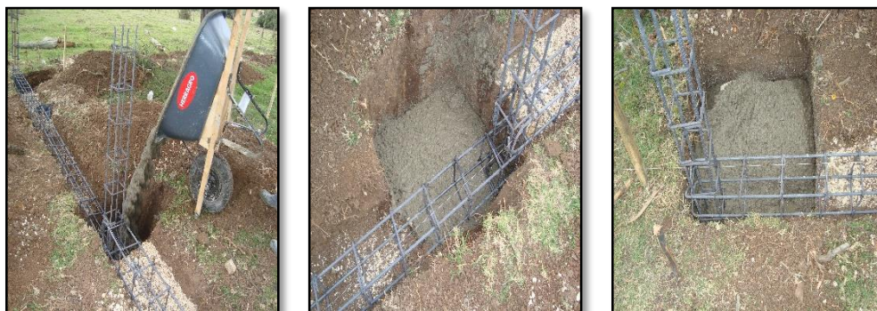
Figura 10. Elaboración de zapatas en concreto 3000 PSI.
