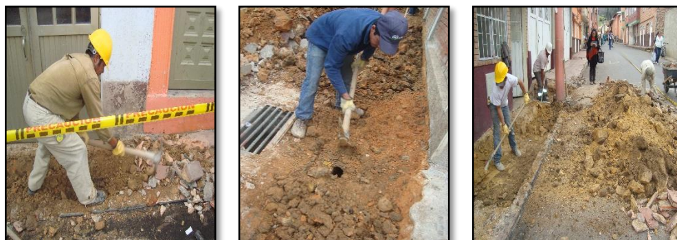
Figura 27. Excavaciones manuales para andenes.
