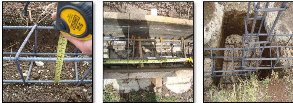
Figura 20. Verificación parámetros de instalación de aceros en vigas.
