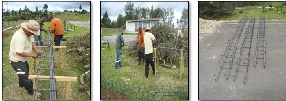
Figura 8: Figurado de acero para vigas de amarre y columnetas.
