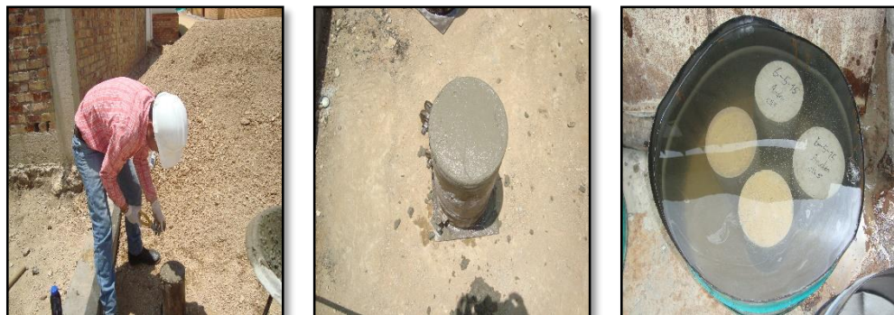
Figura 32. Elaboración de cilindros para muestras de concreto - andenes.
