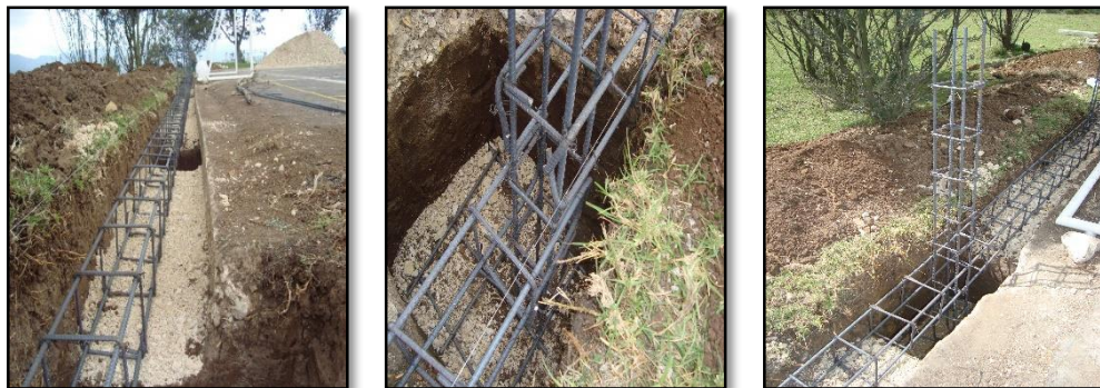
Figura 9: Instalación de acero para vigas de amarre y columnetas.
