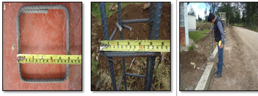
Figura 16. Verificación parámetros de instalación de aceros en columnetas.
