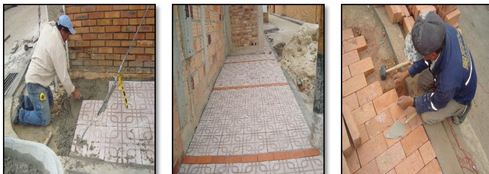
Figura 34. Instalación de losetas y adoquines.
