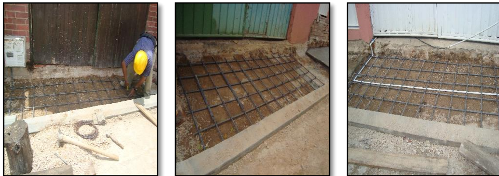
Figura 31. Armado de acero de refuerzo para rampa de andén
