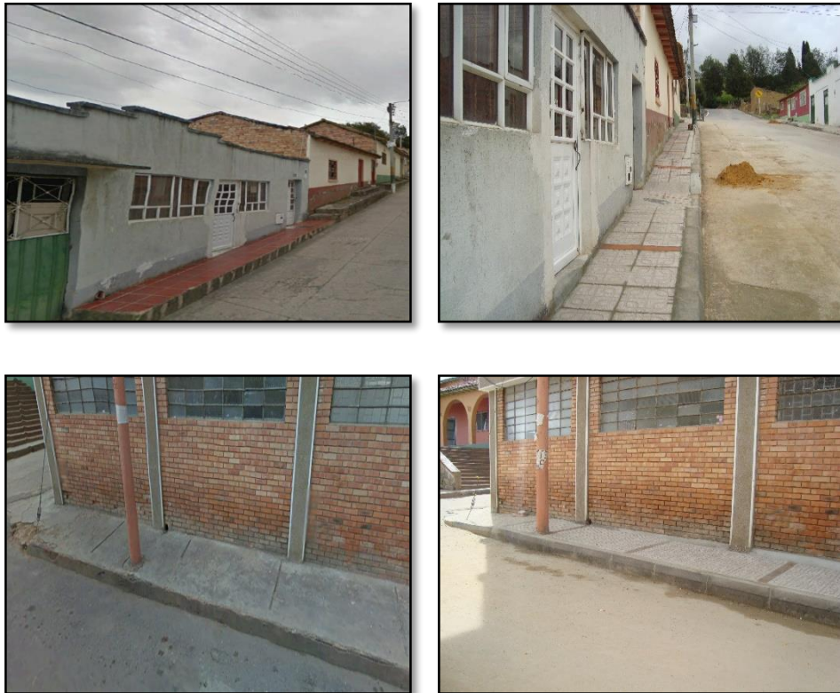
Figura 41. Antes y después construcción de andenes.
