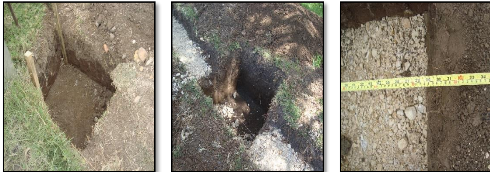
Figura 6: Excavaciones manuales para zapatas.
