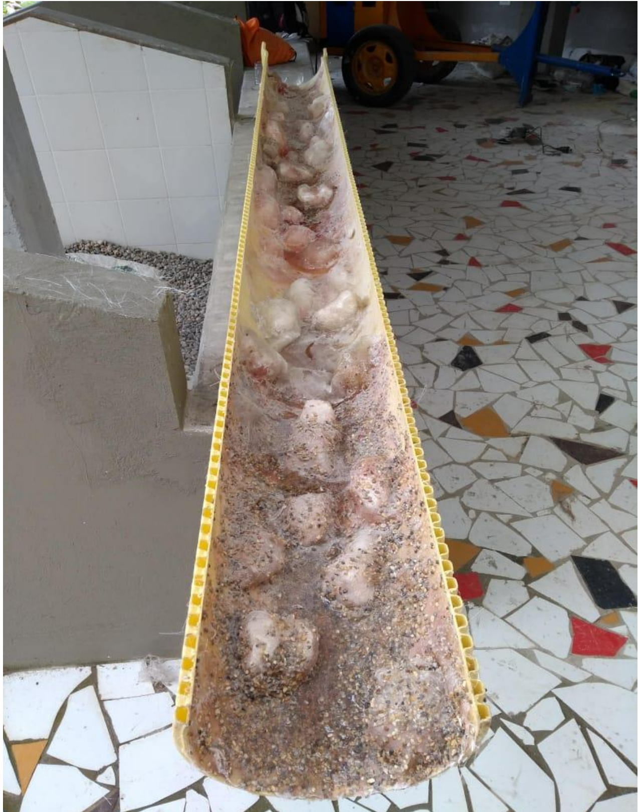
Figura 6 Canal en etapa final de construcción
