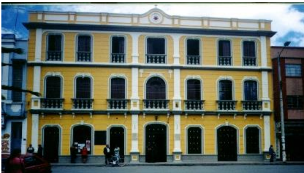
Figura 7: Palacio el Corregidor, tomada de google maps
