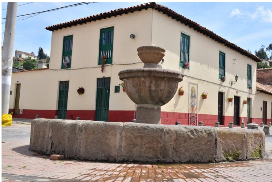
Figura 5: Pila de la unión mochaca, tomada de google maps
