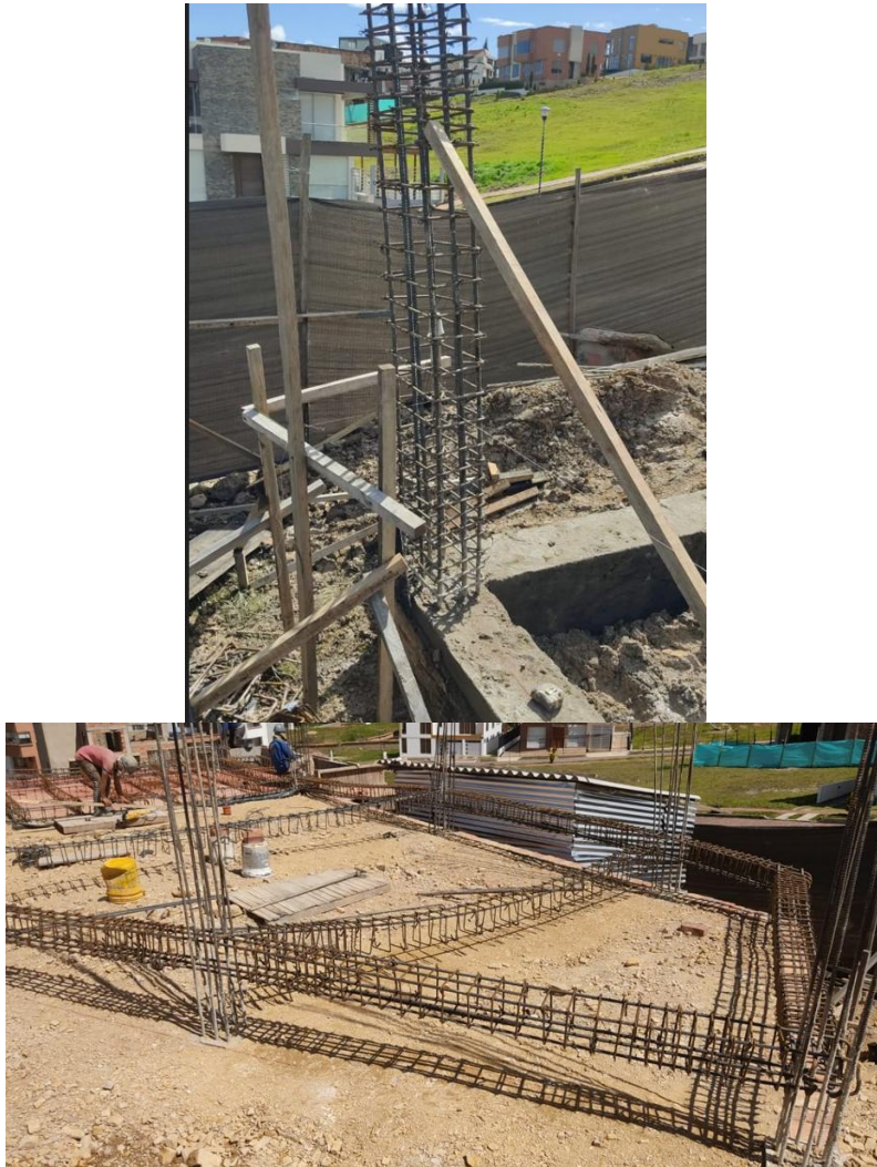
Figura 9: Control técnico estructural en obra.
