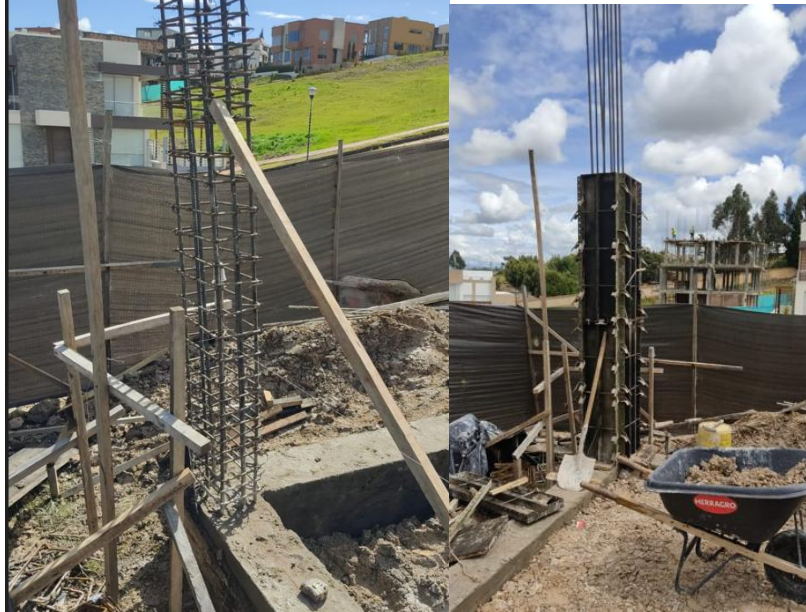
Figura 4: Armado de acero de columnas.
