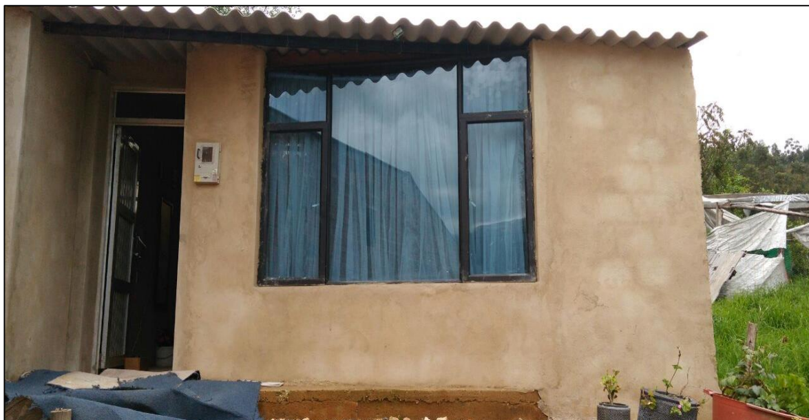
Foto 2. Visita de obra, fotografía de la fachada principal vivienda unifamiliar vereda chorrera primera municipio de Sogamoso.
