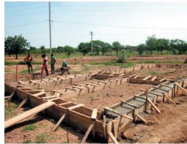
Figura 56 imágenes escuela de educación infantil laaf - tratamiento terreno y cimentación https://www.google.com.co/search?q=Le+Village+Laafi+BASAMENTO&tbm=isch&ved=75
