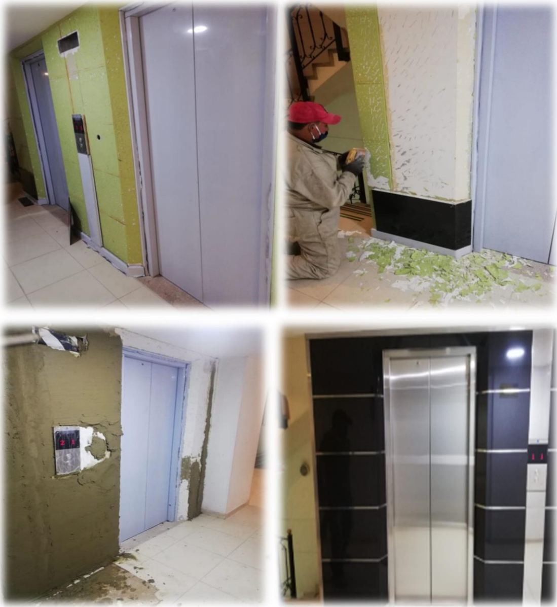
Fig.6. Realización, adecuación y ejecución contrato cambio de fachada y obras civiles conjunto villas de Aranjuez, Fuente: Autor
