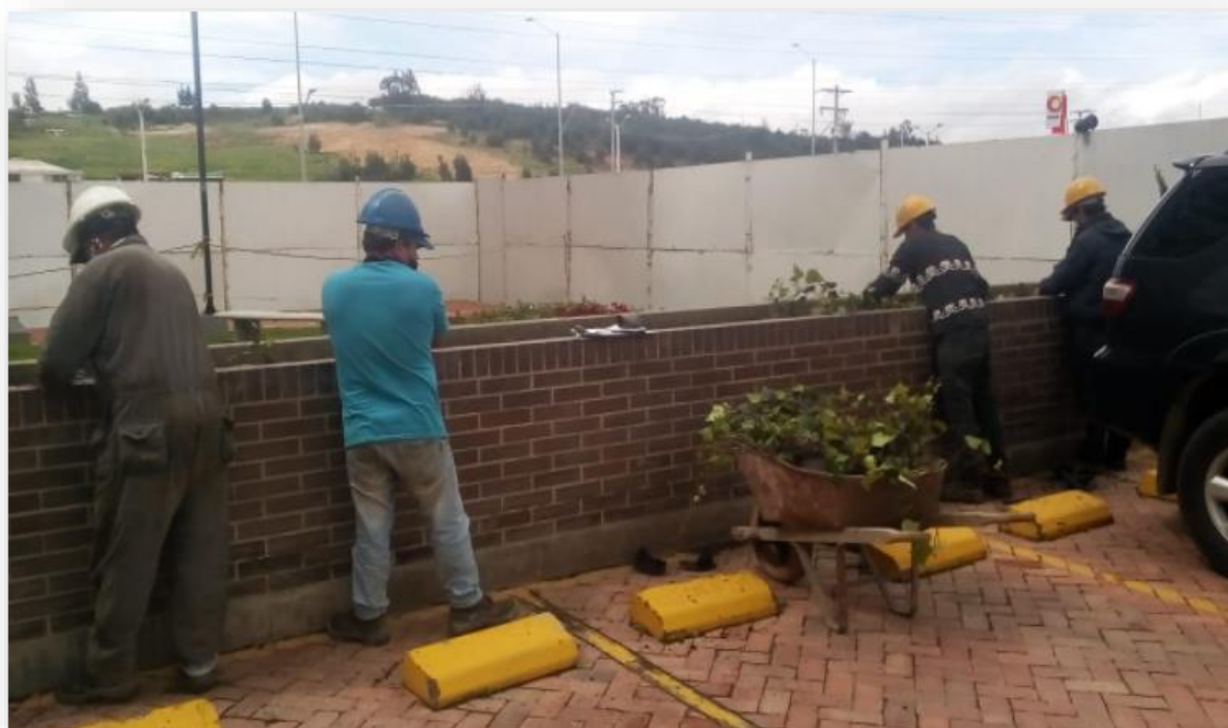
Fig.9. Cuadrilla de trabajo jardinería y paisajismo, utilizando sus respectivos elementos de protección personal Fuente: Autor
