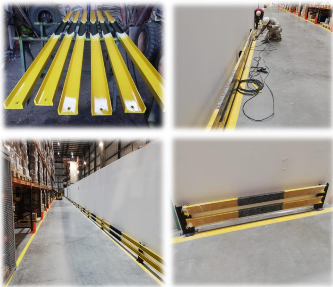
Fig.4 Realización, adecuación y ejecución contrato de barandas industriales en la multinacional B Braun medical. Fuente: Autor
