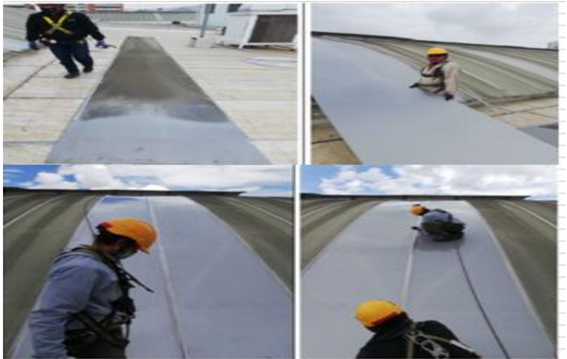
Fig.12. Suministro e instalación de láminas de polycarbonato, Centro comercial Unicentro Tunja Fuente: Autor
