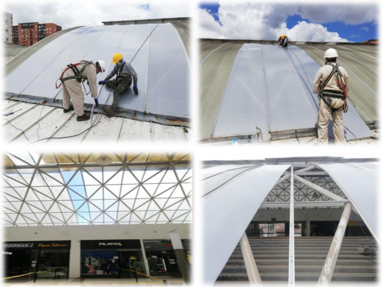
Fig.5 Realización, adecuación y ejecución contrato mantenimiento de cubierta del centro comercial Unicentro Tunja Fuente: Autor
