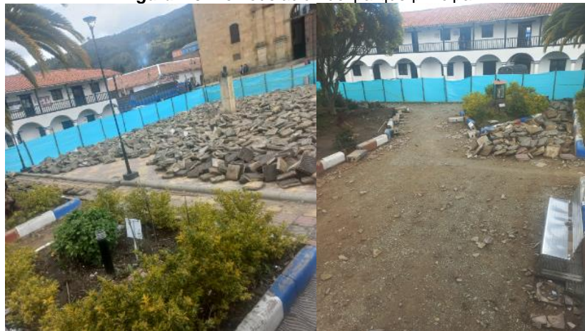
Figura 15. Remodelación del parque principal
