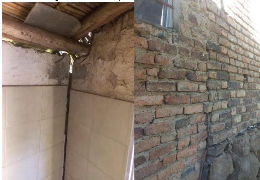
Figura 12. Visita mejoramiento de vivienda Aljibe.
