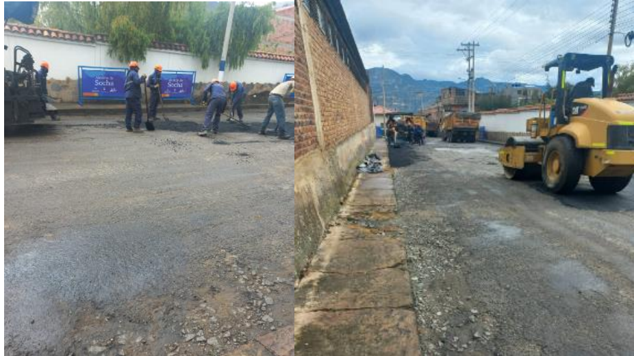
Figura 14. Obras en calles urbanas.
