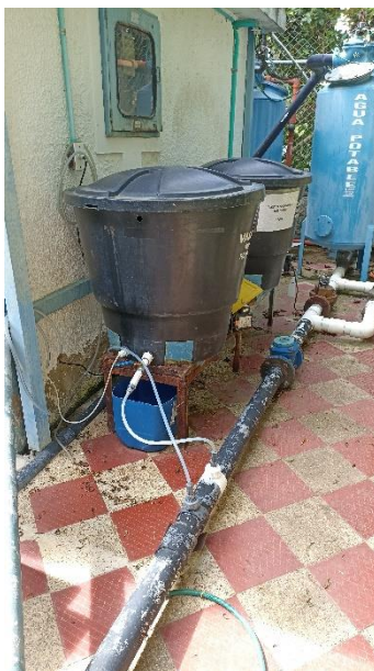
Figura 36 Aplicación de cloro y soda caustica. Fuente propia.
