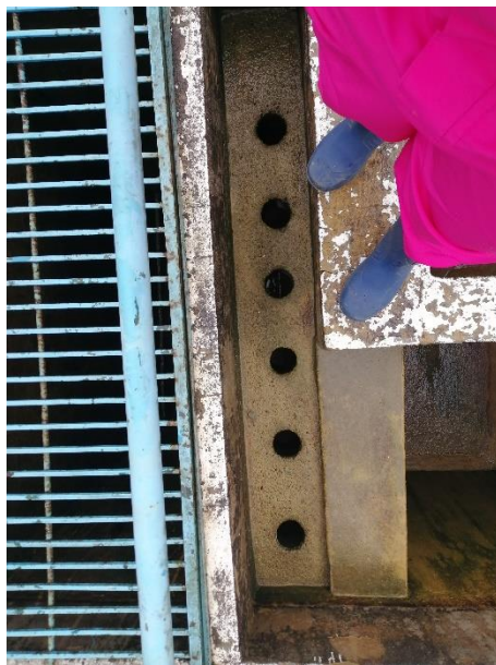
Figura 23 Canal de entrada a los sedimentadores. Fuente propia.
