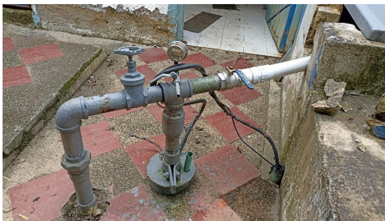
Figura 34 Pozo de succión. Fuente propia.
