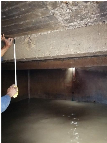
Figura 30 Tanque de almacenamiento visto desde adentro. Fuente propia.
