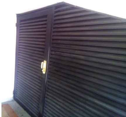
Figura 5. Puerta de ingreso cuarto técnico ubicado en el sector de recepción, tomada por el Autor.
