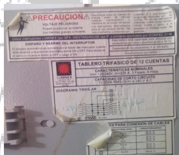
Figura 8. Diagrama unifilar, caja de circuitos 2 sin rotulado, tomada por el Autor.
