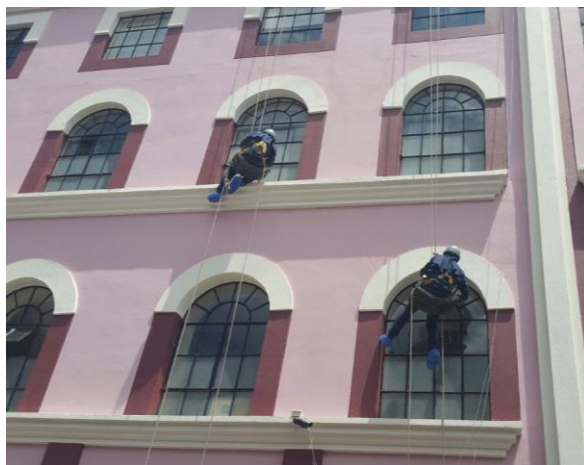
Figura 89. Limpieza de fachada, instalaciones Universidad Santo Tomas, tomada por el Autor
