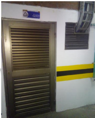
Figura 26. Puerta de ingreso cuarto técnico ubicado en el sector de garaje, tomada por el Autor.
