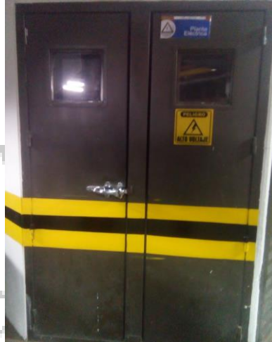
Figura 35. Instalación Planta Eléctrica, tomada por el Autor.
