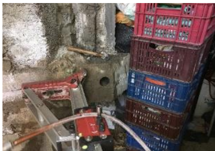
Fuente: Elaboración propia Fecha: 09/03/18 Fotografía 6- Extracción de núcleos (columna, viga y contrafuerte)
