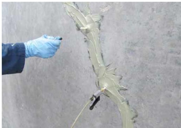
Fuente: brochure sika, inyección de fisuras Fotografía 9- Aplicación de resina para fisuras y sellado de las mismas
