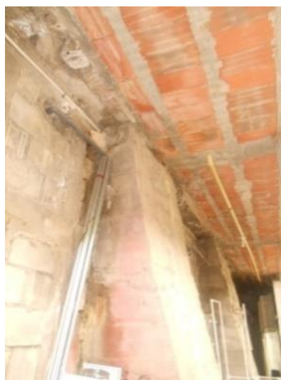
Fuente: Elaboración propia Fecha: 24/11/17 Fotografía 1- Muro de contención SENA y hotel casa Amárela
