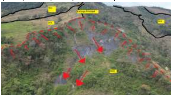
Fotografía 41. SubTramo PR79+800 - PR80+150 (Parte Superior de la Vía): (Sr/Rdm/Kilm), suelo residual/roca degradada y meteorizada de rocas de formación Lutitas de Macanal, Se evidencia el terraceo que se presenta por un proceso de reptación.
