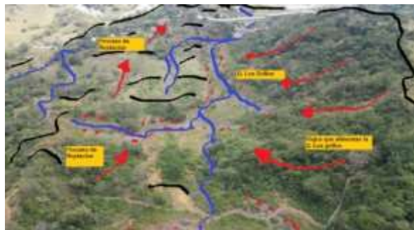
Fotografía 44. SubTramo PR81+100 - PR81+300 (Parte Superior de la Vía): Se evidencia proceso de reptación, debido a cambios estacionales de lluvia y temperatura, las lutitas presentan, hinchamiento y contracción, provocando el empuje y desplazamiento de la masa.
