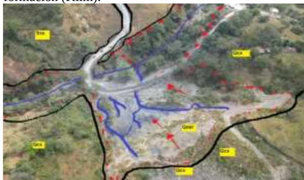
Fotografía 48. SubTramo PR82+300 - PR82+800, (Qcx), depósitos o geoformas coluviales de diferentes tiempos, Se evidencia socavación y ensanchamiento del canal natural del cuerpo hídrico; (Sr/Rdm/Kilm), suelo residual/ roca degrada y meteorizada de la formación lutitas negras con esporádicas intercalaciones de calizas areniscas.
