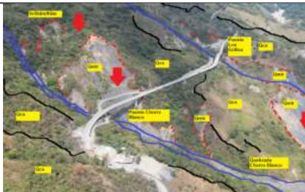
Fotografía 46. SubTramo PR81+700 - PR82+100, (Qcx), Se evidencia deslizamiento, deposito coluvial de diferentes tiempos; en las fotografías tomadas en el año 1979 presentaba una situación similar; (Sr/Rdm/Kilm), Suelo residual/ roca degradada y meteorizada de la formación (Kilm).
