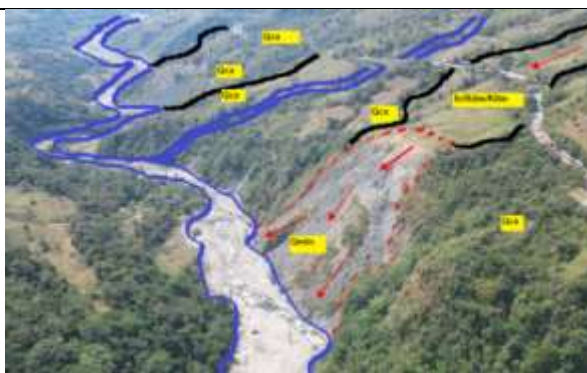
Fotografía 42. SubTramo PR79+800 - PR80+150 (Parte Inferior de La vía): (Qcx), depósitos coluviales de diferentes tiempos. Se evidencia deslizamiento tipo Caída.
