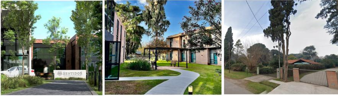
Figura 55. Vistas fotográficas exteriores
