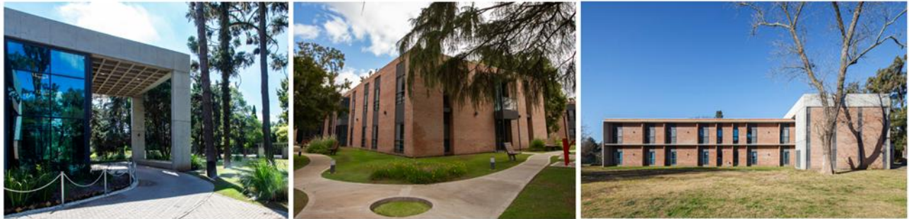
Figura 58. Vistas fotográficas materialidad exterior
