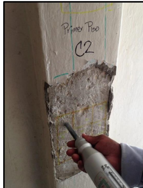
Columna C2 – Primer piso
