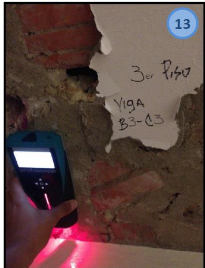
Detección de refuerzos en viga B3-C3 – Tercer piso Caras escaneadas: Inferior
