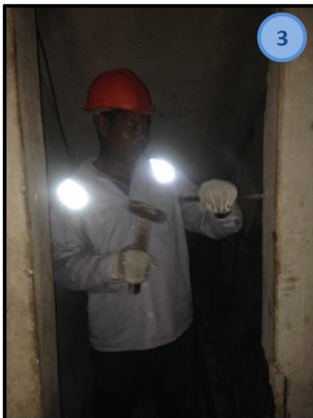
Detección de refuerzos en columna C'3 – Primer piso
