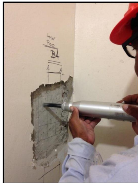
Columna B4 – Tercer piso
