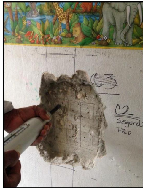
Columna C2 – Segundo piso
