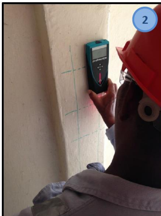
Detección de refuerzos en columna C2 – Primer piso
