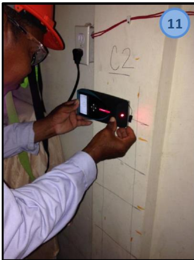
Detección de refuerzos en columna C2 – Tercer piso
