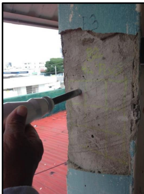
Columna B3 – Cuarto piso
