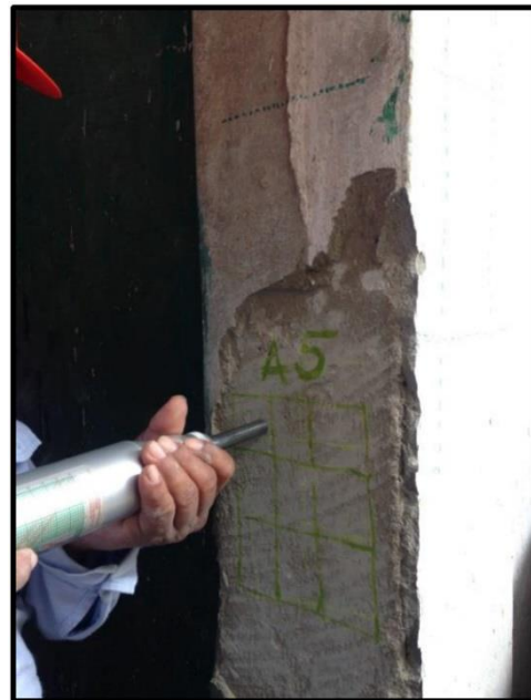
Columna A5 – Primer piso
