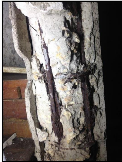
Columna C'4 – Primer piso
