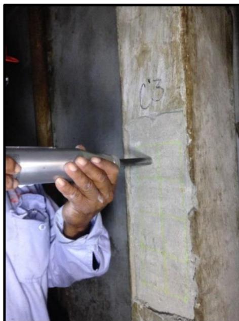
Columna C'3 – Primer piso
