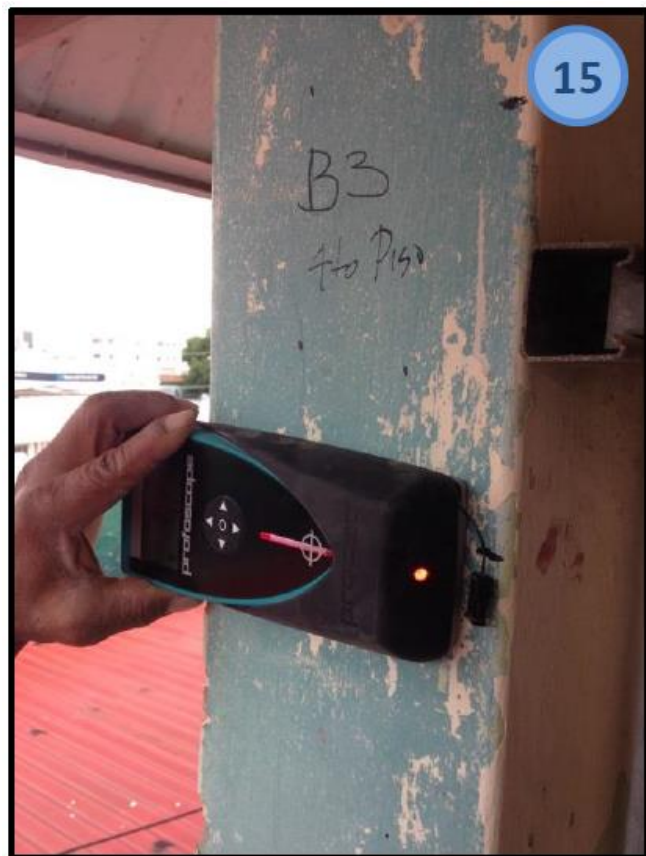
Detección de refuerzos en columna B3 – Cuarto piso
