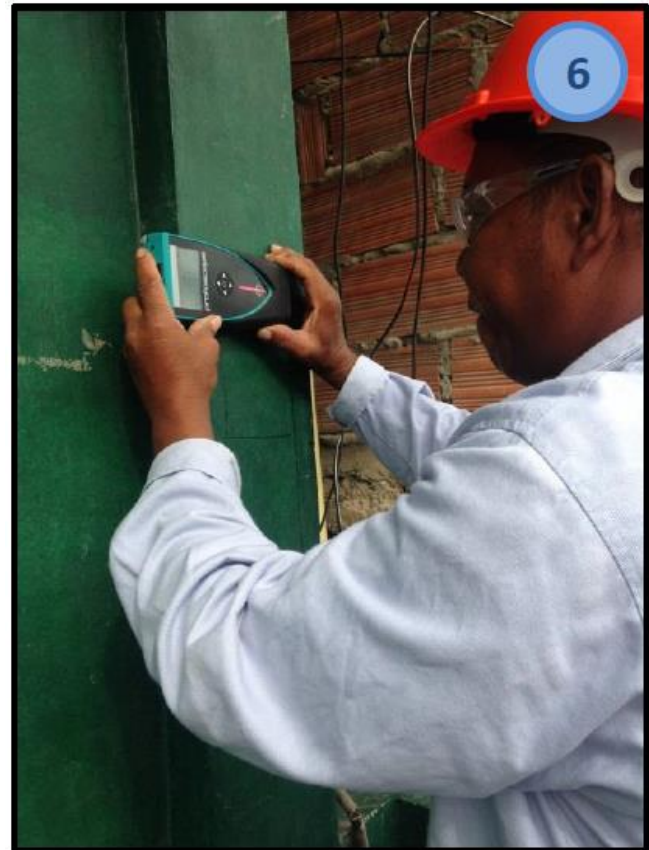
Detección de refuerzos en columna A1 – Segundo piso
