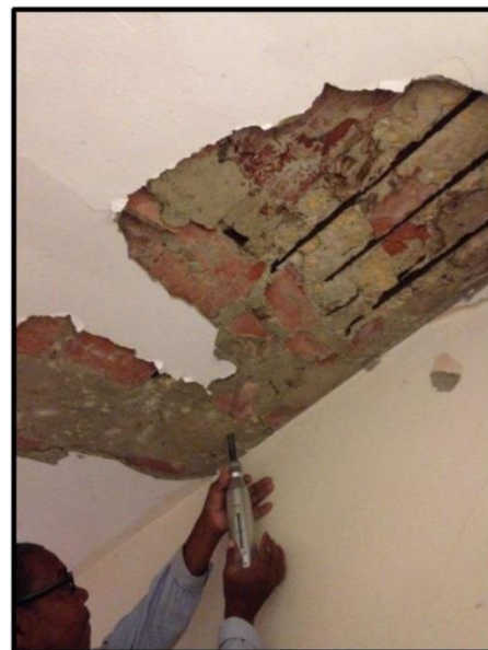
Viga entre B3 – C3 – Tercer piso
