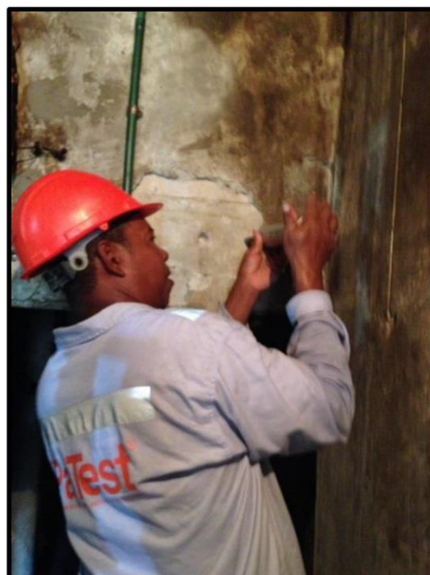
Viga entre C3 – C'3 – Primer piso
