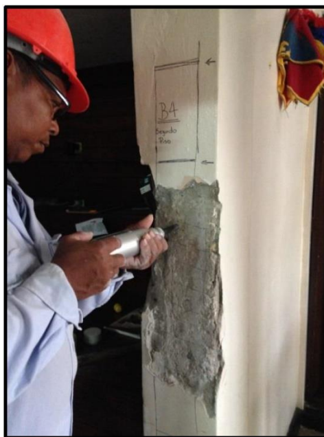
Columna B4 – Segundo piso
