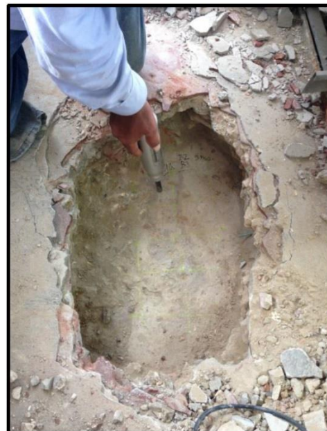
Viga entre B3 – B4 – Tercer piso
