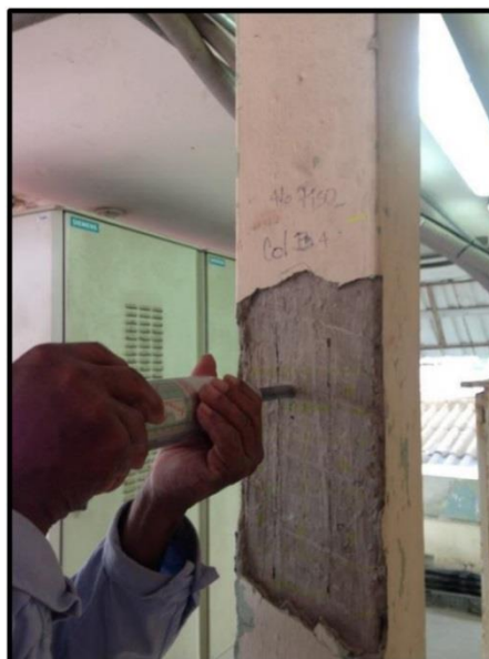
Columna B4 – Cuarto piso
