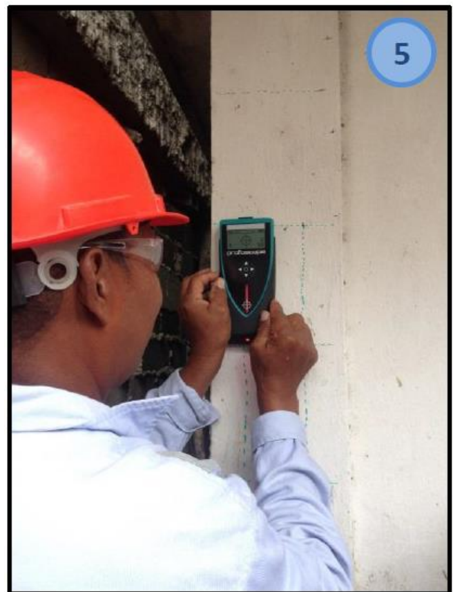
Detección de refuerzos en columna C2 – Primer piso
