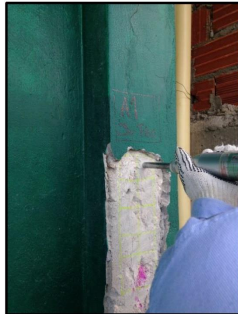
Columna A1 – Tercer piso
