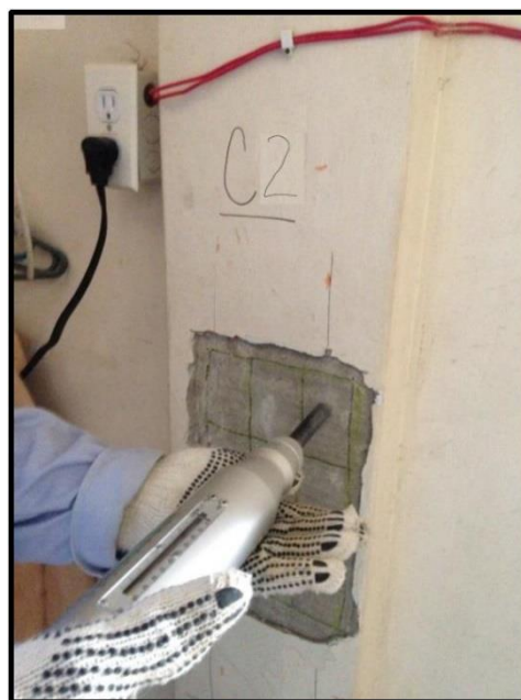
Columna C2 – Tercer piso
