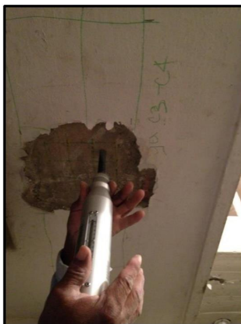
Viga entre C3 – C4 – Segundo piso
