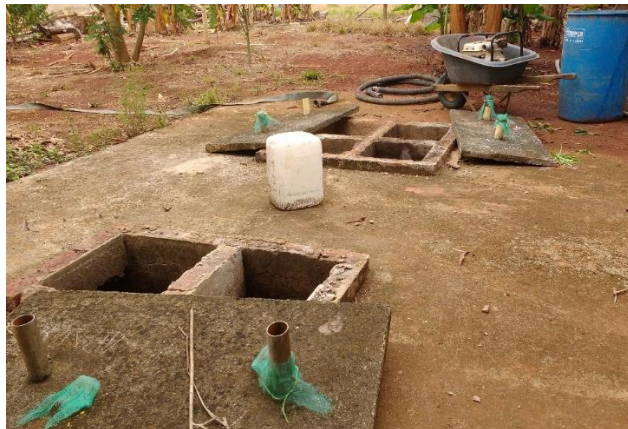
Fig.18. Mantenimiento de pozo séptico
