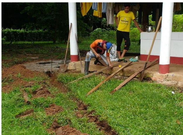
Fig.19. Mantenimiento pozo séptico de Panorama
