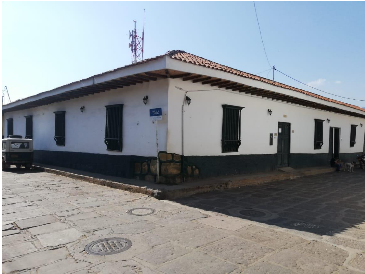
Figura 25. Vista de la actual casa de la cultura
