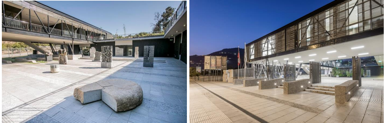
Figura 13. Centro cultural el tranque, vista interiores
