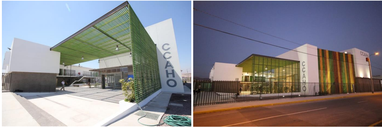
Figura 16. Centro cultural alto hospicio, vistas exteriores de la zona de acceso
