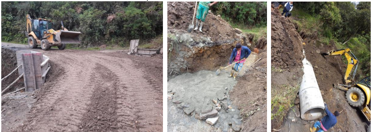
Ilustración 7 Supervisión construcción alcantarillas
