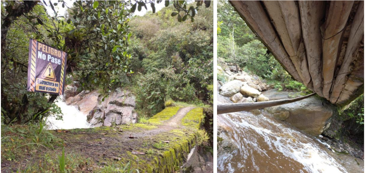
Ilustración 16 Visita gestión del riesgo puente sobre la quebrada Colorada
