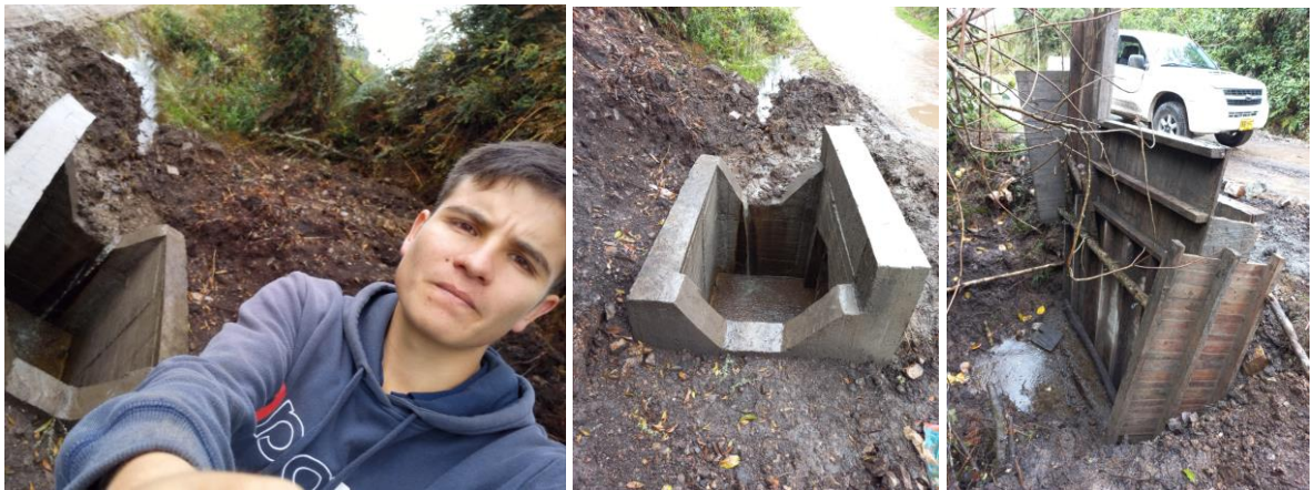
Ilustración 6 Visita construcción alcantarillas
