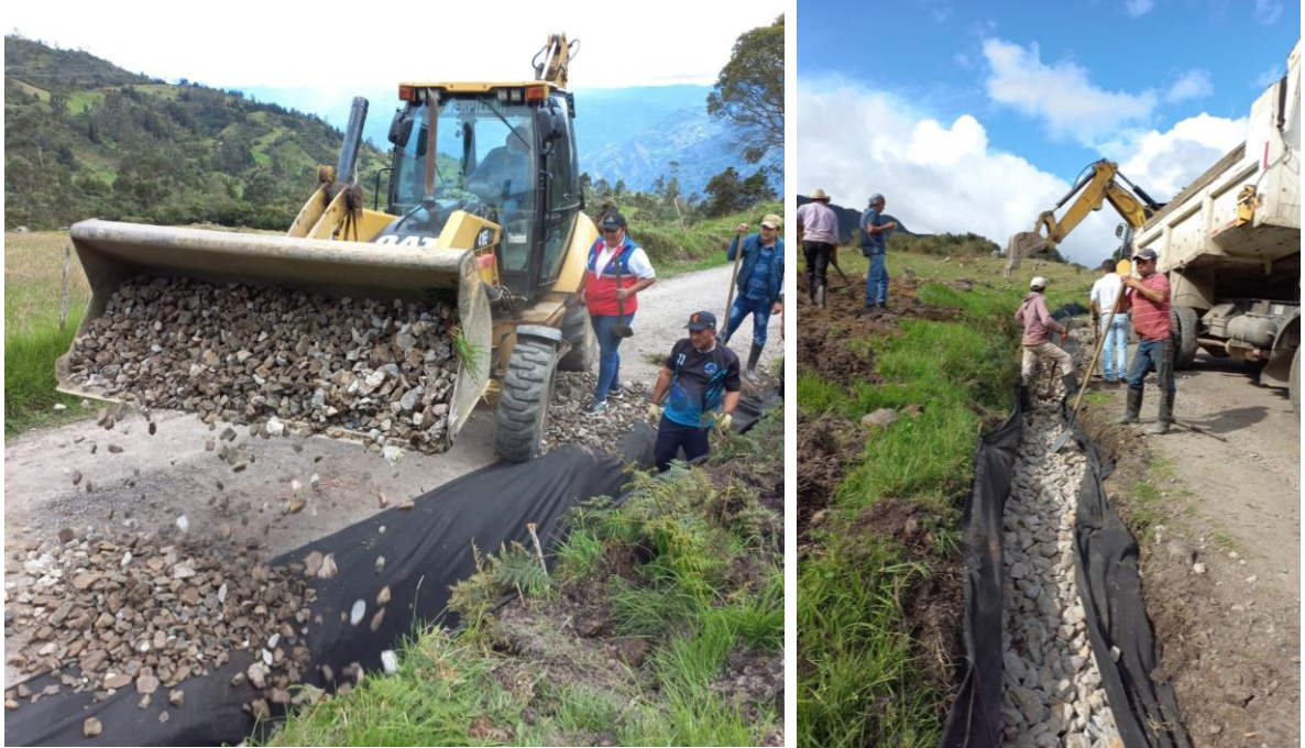
Ilustración 8 Supervisión construcción de filtro
