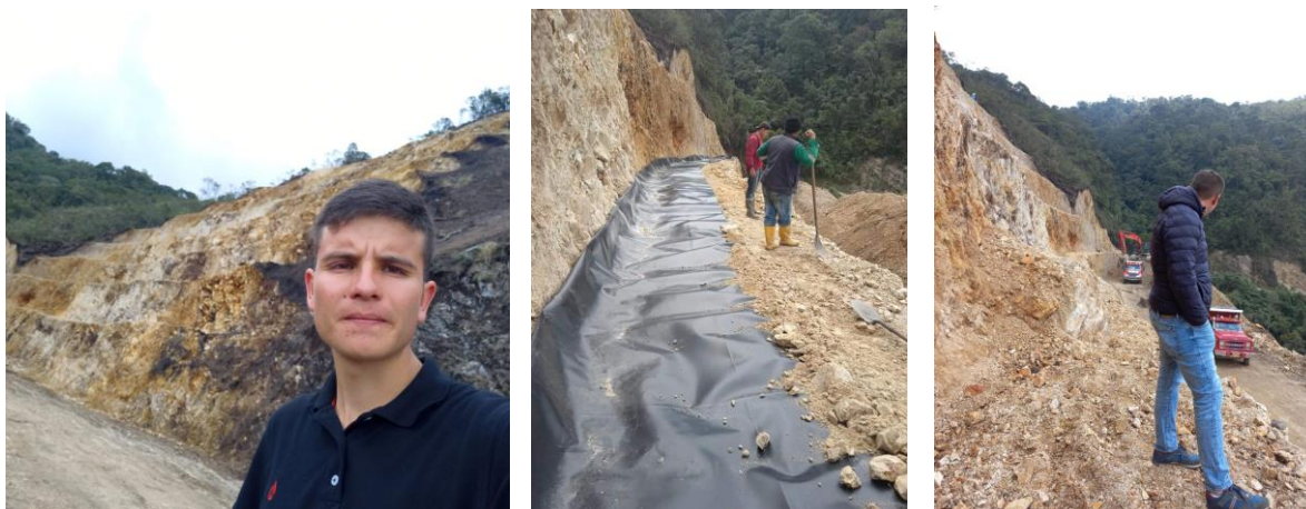
Ilustración 4 Estabilización talud mediante sistema de terrazas
