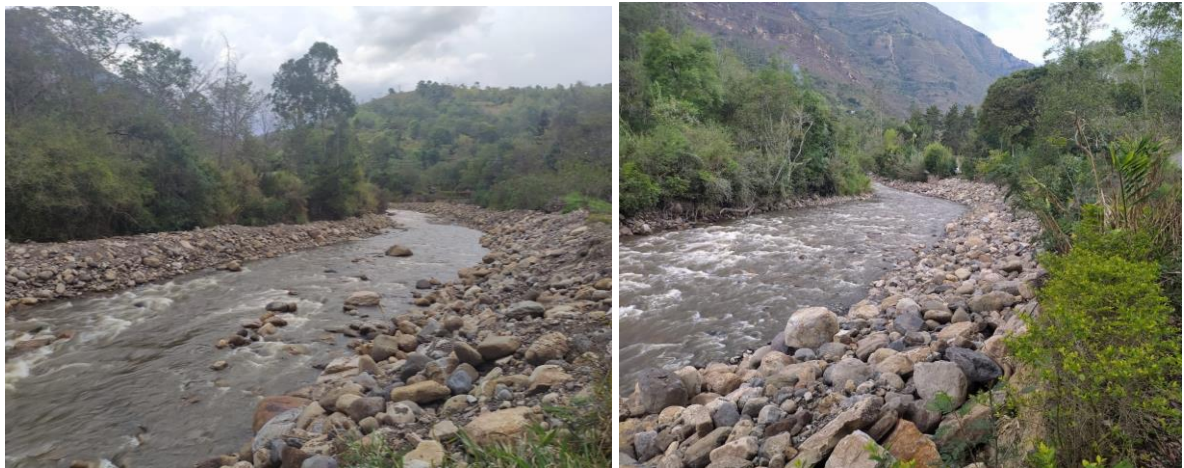
Ilustración 17 Visita estabilidad de la obra de contención mediante jarillones
