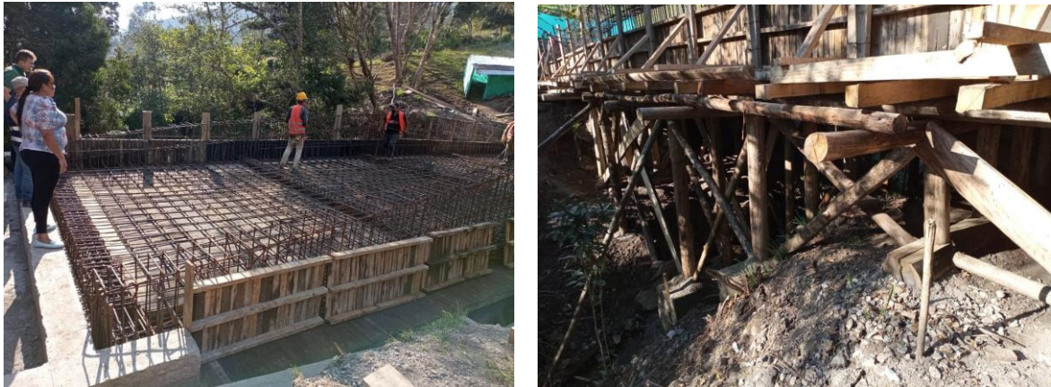
Ilustración 5 Visita puente vehicular vereda San Antonio
