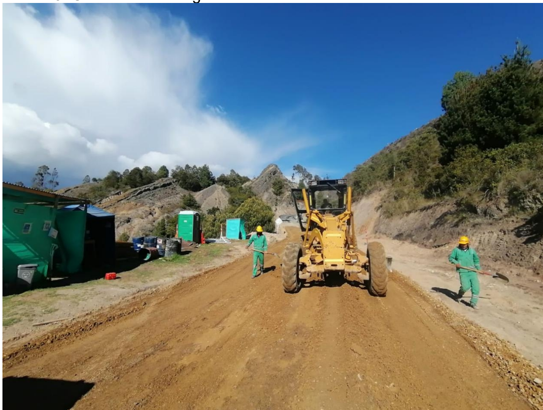
Ilustración 9. Colocación base granular
