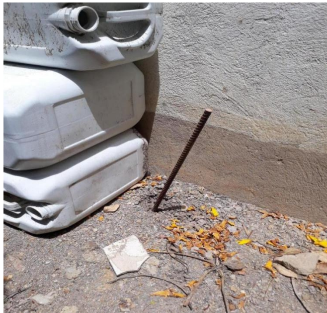
Ilustración 17. Evidencia de relleno
