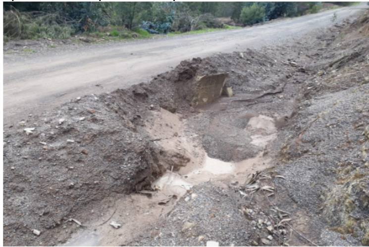
Ilustración 20. Taponamiento producido por el arrastre de material
