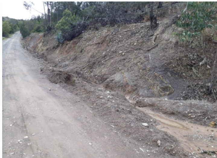
Ilustración 21. Colina aledaña a la alcantarilla
