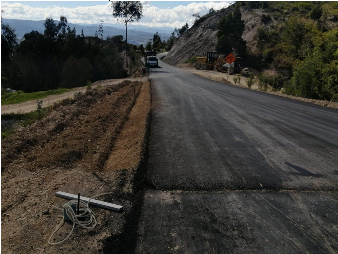
Ilustración 8. Colocación carpeta asfáltica
