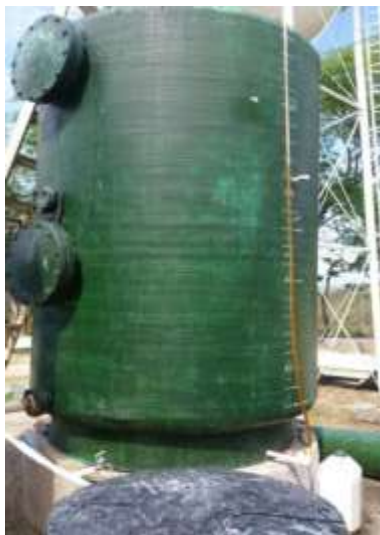
Imagen 12. Mezclador Rápido (uno de los dos tanques)
