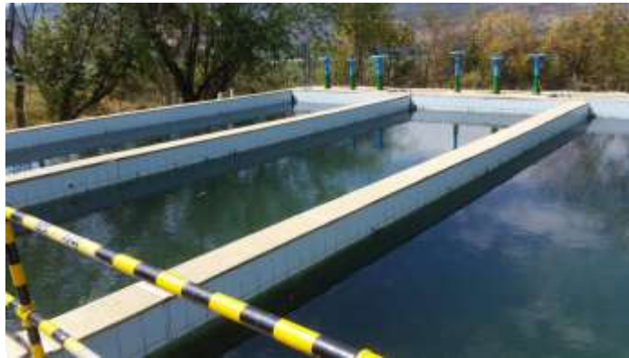
Imagen 14. Tanques de sedimentación
