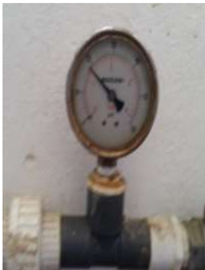
Imagen 20. Manómetro presión de Cloro
