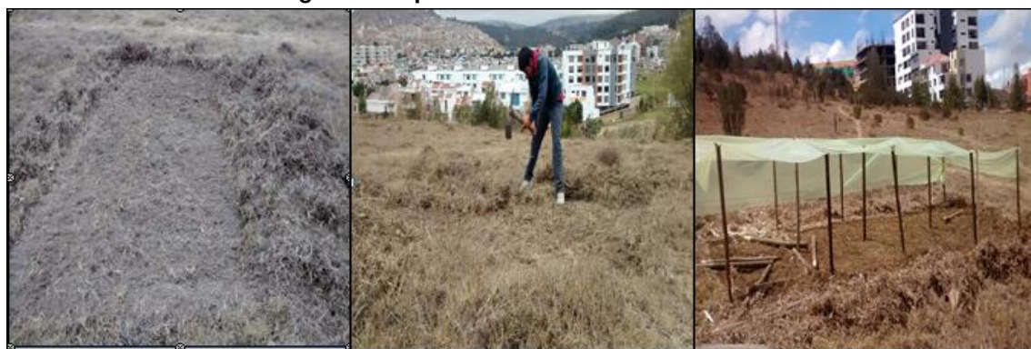
Imagen 4. Preparación del sitio de tratamiento
