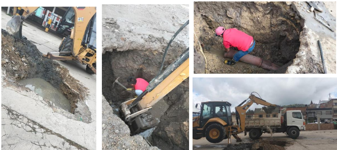
Figura 38. Arreglo de tubería de alcantarillado del sector plaza de mercado.
