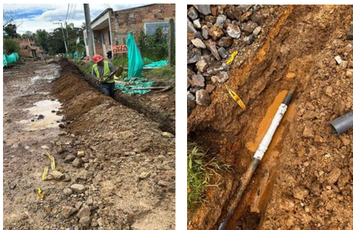
Figura 32. Arreglo en red principal de acueducto.
