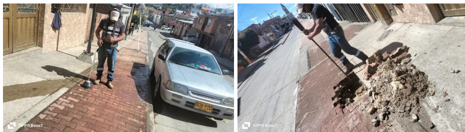
Figura 30. Gestión operativa para el manejo de fugas con la ayuda del monitoreo por medio del geófono.
