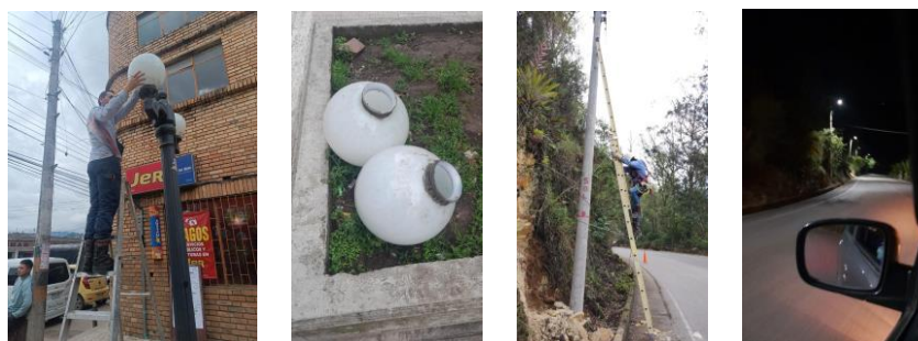
Figura 39. Mantenimiento de alumbrado público.
