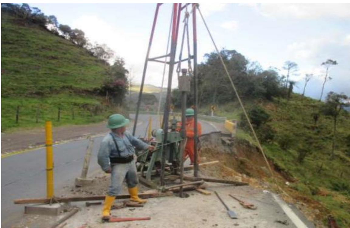
Fotografía 17. Equipo de perforación manual- Sondeo No1. Fuente: de este estudio - 2017
