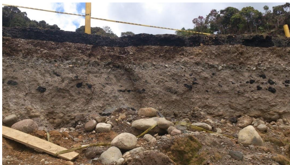
Fotografía 2. Estructura pavimento, sub-base, base y carpeta PR19+0600. Fuente: de este estudio – 2017
