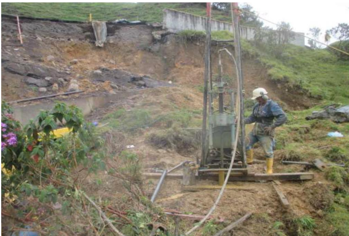
Fotografía 19. Ejecución del Sondeo No3. Fuente: de este estudio - 2017
