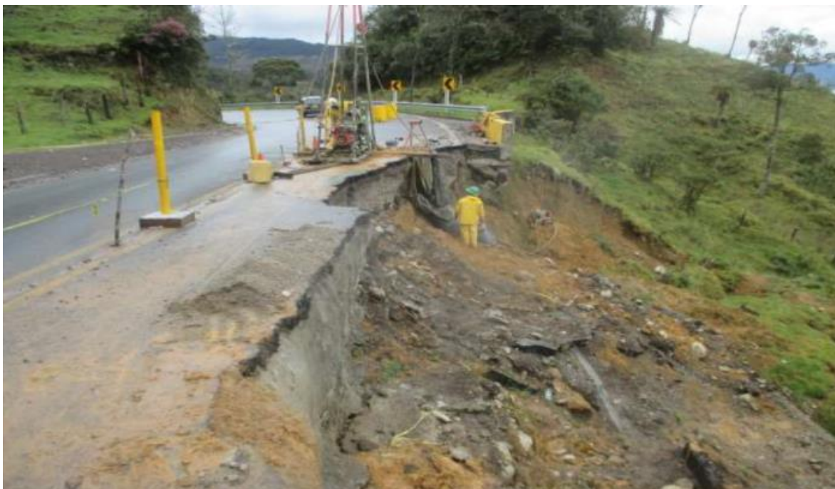
Fotografía 18. Ejecución del Sondeo No2. Fuente: de este estudio – 2017
