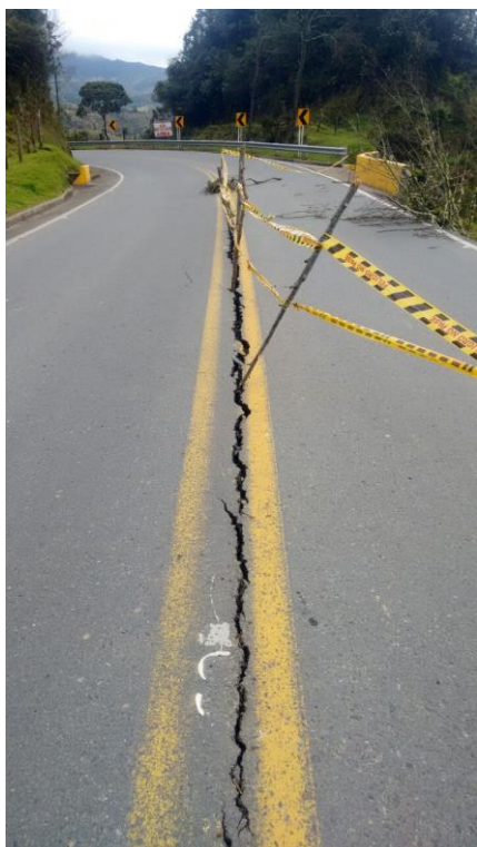
Fotografía 4. Evolución a Grieta longitudinal PR19+0600. Fuente: de este estudio – 2017
