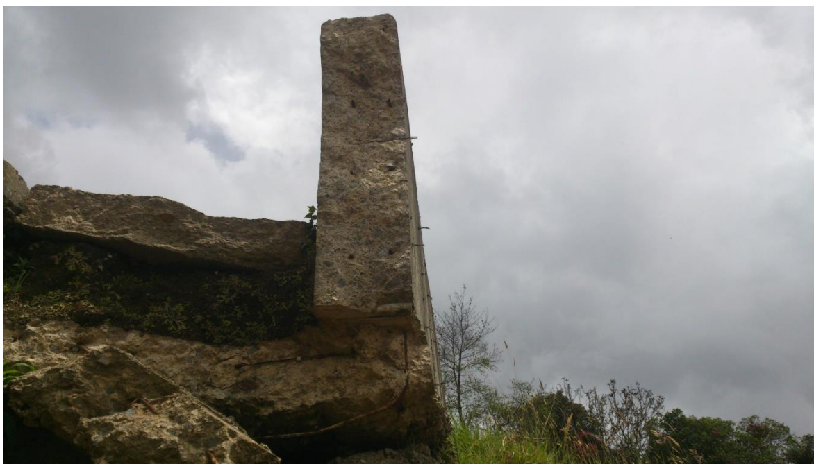
Fotografía 10. Sección de la estructura de confinamiento PR19+0621. Fuente: de este estudio – 2017
