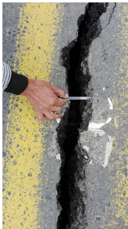
Fotografía 4. Evolución a Grieta longitudinal PR19+0600. Fuente: de este estudio – 2017
