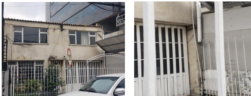
Figura 17: Afectación de predios vecinos. Fuente: Propia.
