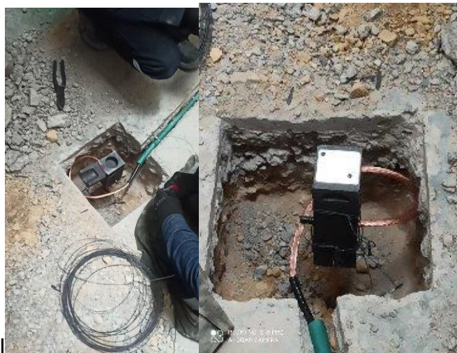
Imagen 18 y 19 Posicionamiento de cable y varilla a molde (Proceso en video “Anexos”). Fuente equipo técnico Enercer
