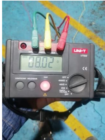
Imagen 21. Segunda toma de resistencia con hidrosolta a puesta a tierra. Fuente equipo técnico Enercer
