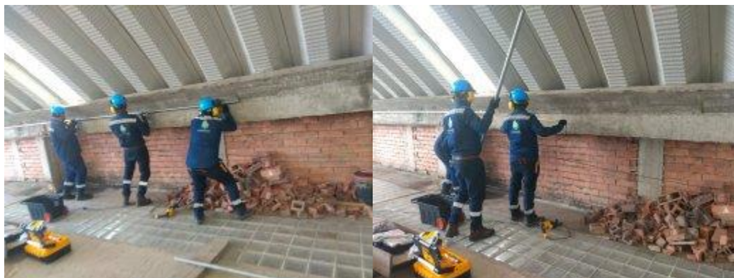
Imagen 11 y 12. Instalación de tubería EMT con uniones y abrazaderas. Fuente equipo técnico Enercer
