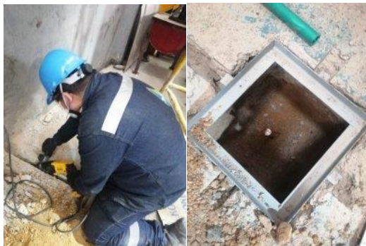
Imagen 15 y 16. Excavación y puesta de varilla de cobre – instalaciones de tierra. Fuente equipo técnico Enercer
