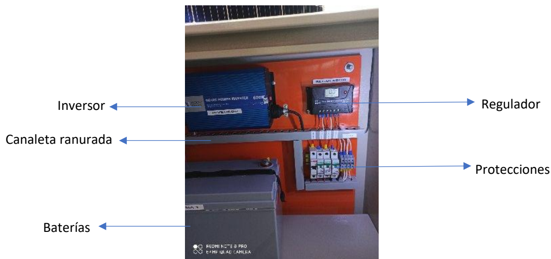
Imagen 29. Ensamble KIT solar 330, Fuente equipo tecnico Enercer
