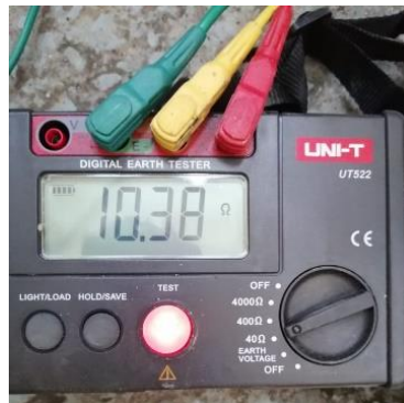
Imagen 20. Primera toma de resistencia a puesta a tierra. Fuente equipo técnico Enercer
