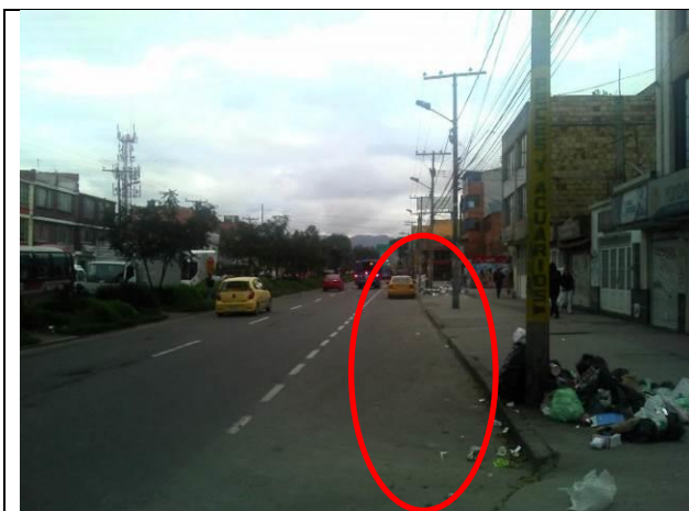
Bahía utilizada de forma inadecuada. Ubicada en la CI 72 entre Cr 98A
