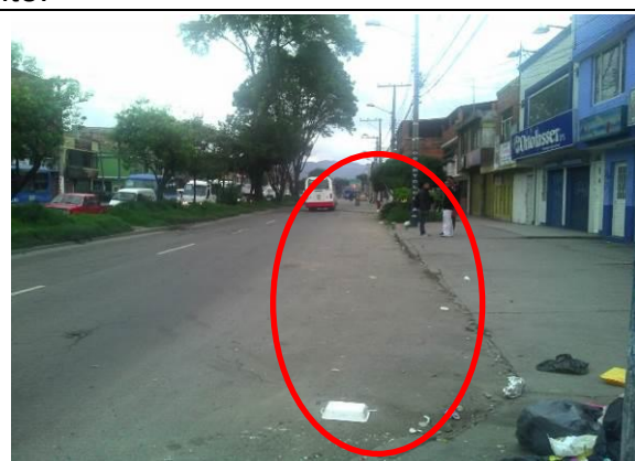
Bahía utilizada de forma inadecuada. Ubicada en la CI 72 entre Cr 99B
