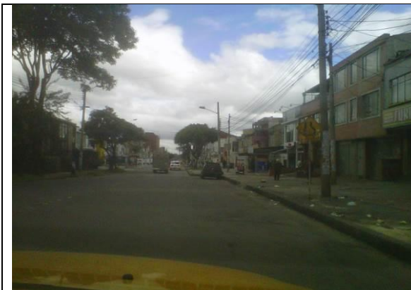
Bahías de parqueo sin aprovechar. Carrera 24 con calle 47.
