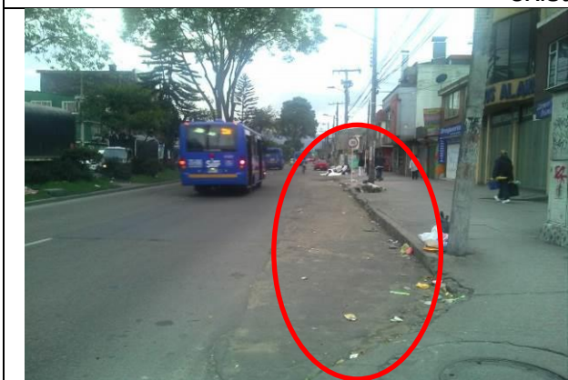
Bahía utilizada de forma inadecuada. Ubicada en la CI 72 entre Cr 100 a y 99c
