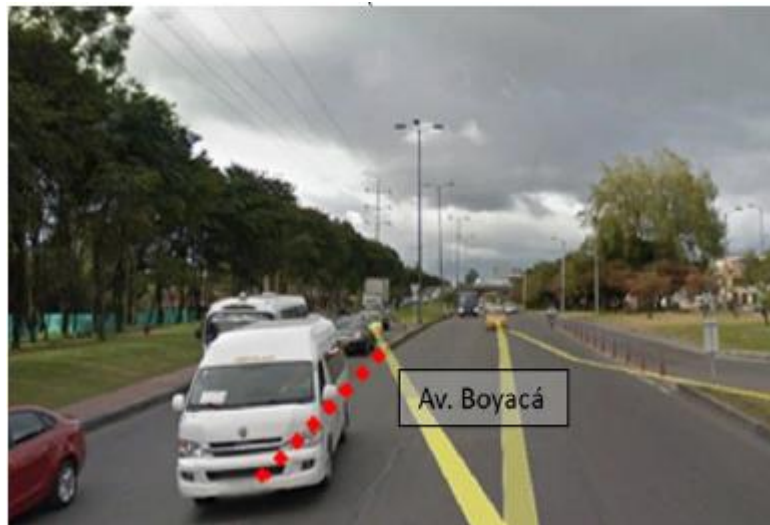
FIGURA 85 ESTADO ACTUAL SALIDA PUENTE VEHICULAR CLL 116 X AV BOYACÁ
