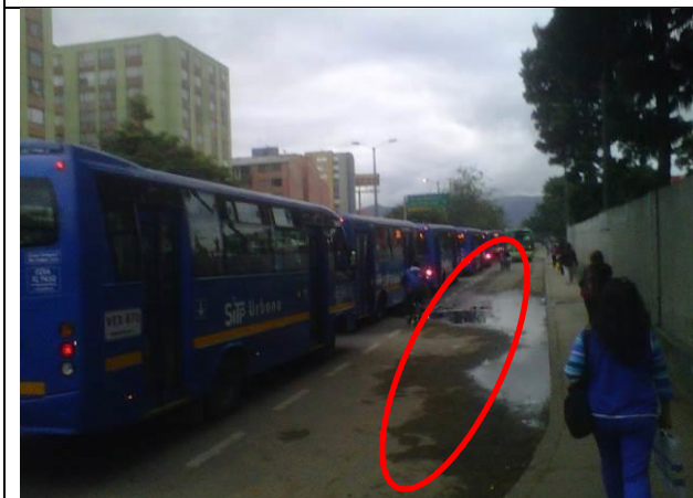
Bahía utilizada de forma inadecuada.
