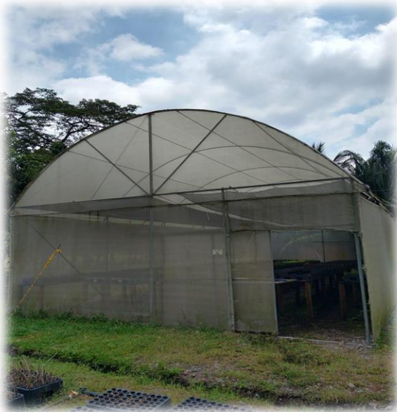
Figura 15. Parte exterior del invernadero.
