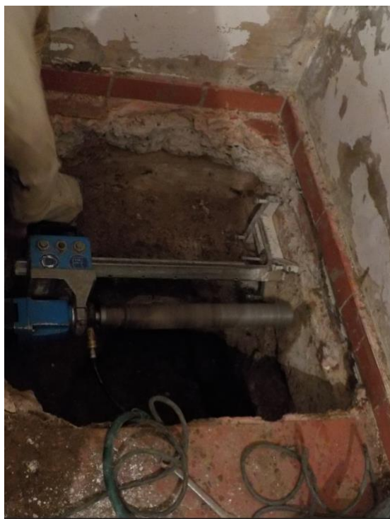
Fotografía 1: Cimentación en desplante de mampostería y viga de concreto SIMPLE
