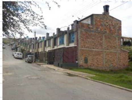
Ilustración 11: La urbanización está conformada por mampostería sin refuerzo.
