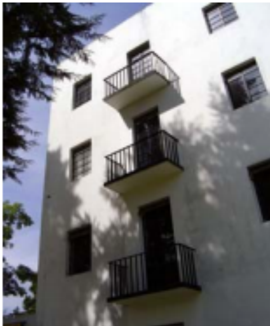
Figura 42. Edificio De Vivienda Estudiantil.
