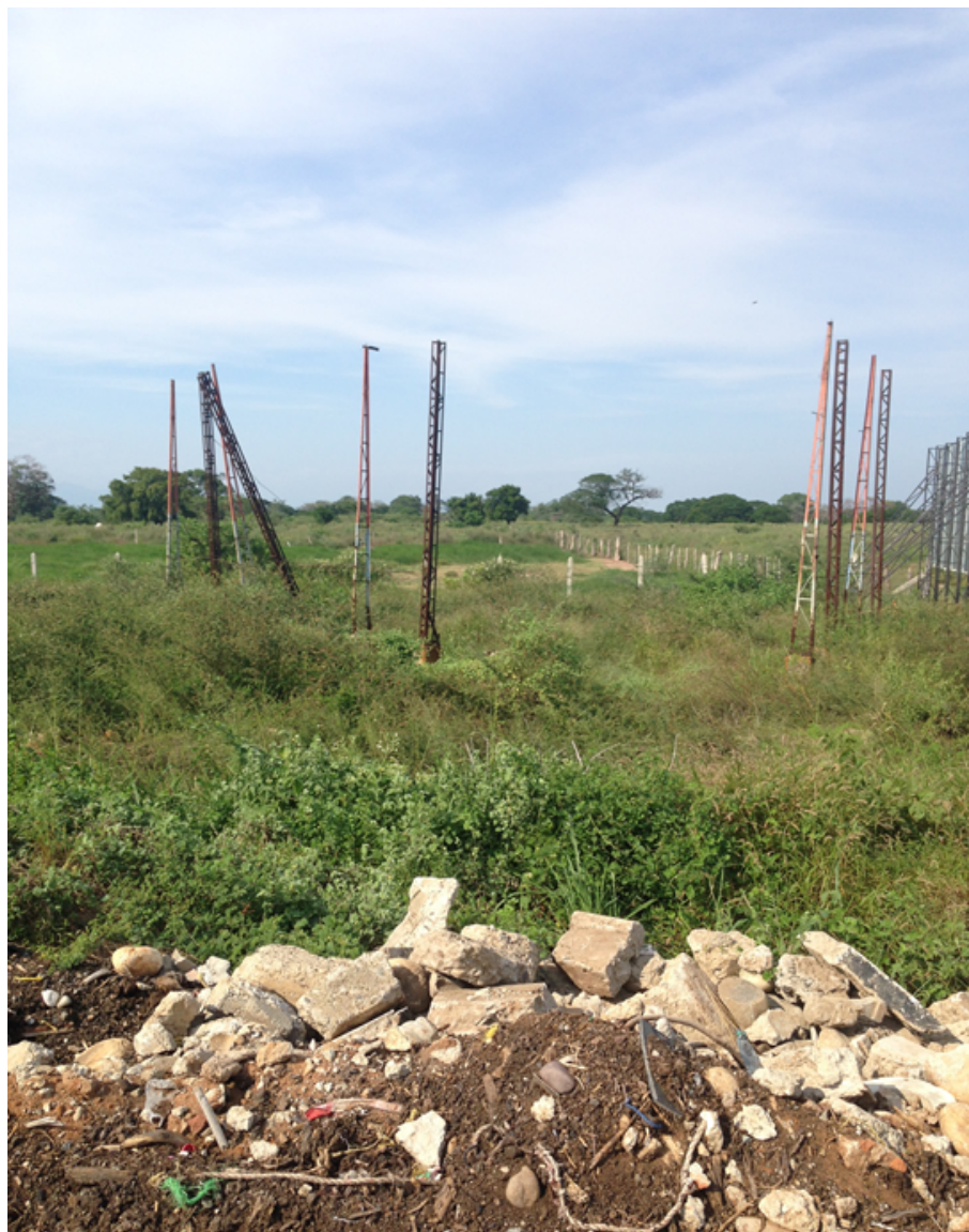
Figura 56. Estado Actual Del Lote 1. Fuente: AUTOR.
