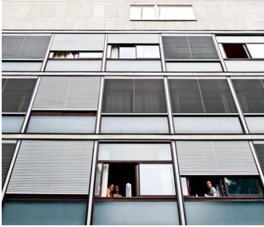
Figura 36. Habitaciones Pabellón Suizo.
