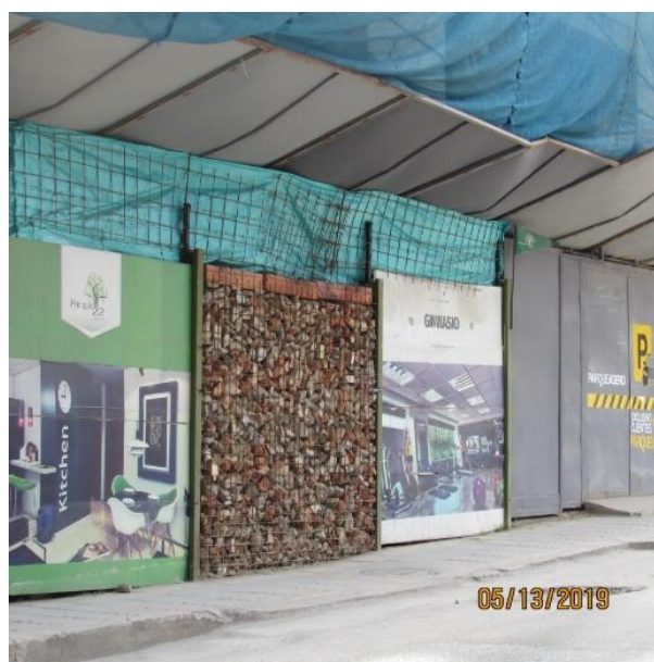
Figura 66. Cerramientos temporales “innovadores” instalados. Fuente: Autor
