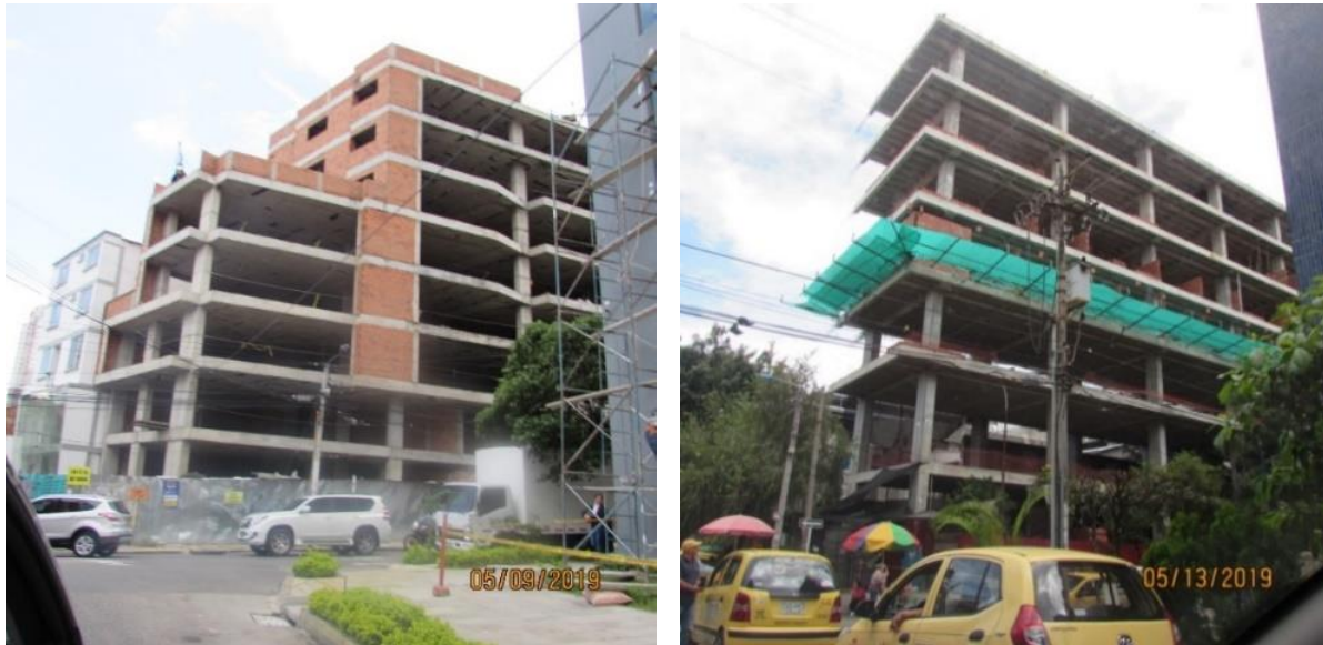
Figura 40. Medidas incompletas de protección para la caída de objetos.
