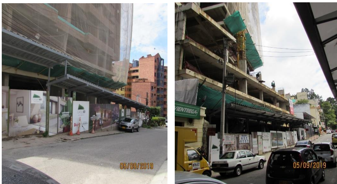
Figura 67. Implementación de cerramiento con pórtico peatonal.
