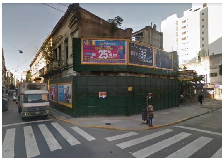
Figura 4. Cerramiento provisional en Argentina. Fuente: Google Maps
