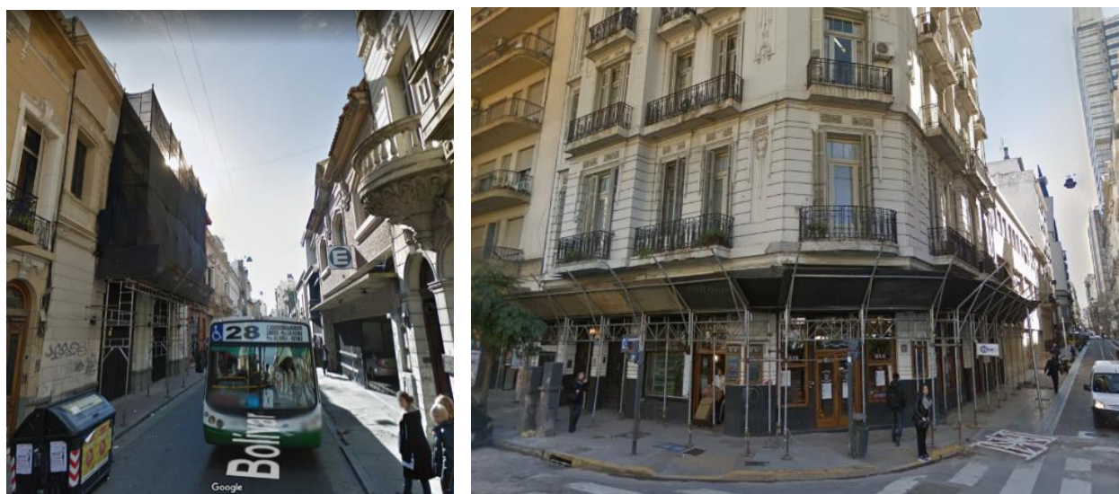
Figura 5. Andamios y protecciones a la vía pública en Argentina.
