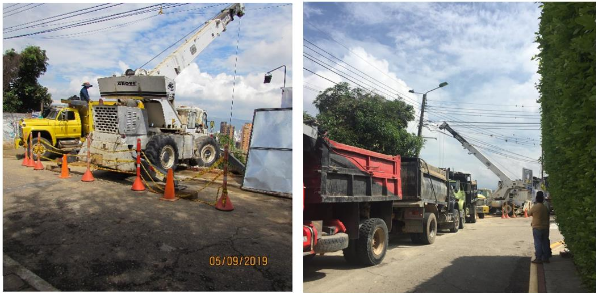
Figura 74. Evidencia de la ocupación temporal de vías ocasionado por vehículos y maquinaria vinculada a la obra. Fuente: Autor
