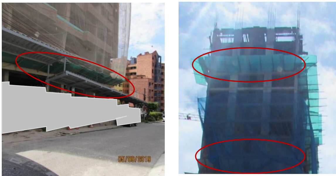
Figura 41. Se implementan mallas y bandejas de protección.
