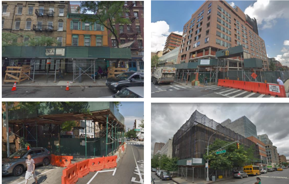
Figura 7. Adecuación de circulaciones peatonales para el tránsito protegido.
