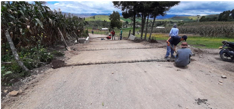
Ilustración 20 Colocación de Riostras en terreno
