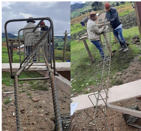
Ilustración 17 Armado Acero de Refuerzo
