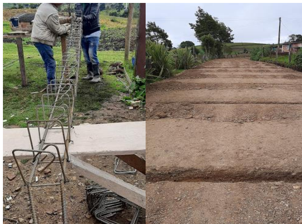
Ilustración 5 Riostra con excavación
