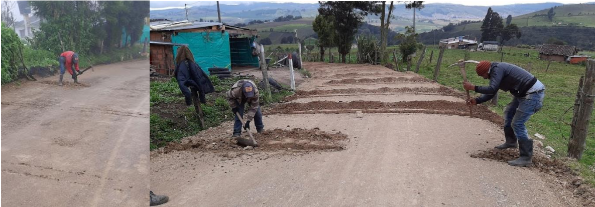
Ilustración 16 Excavación Manual de Riostras
