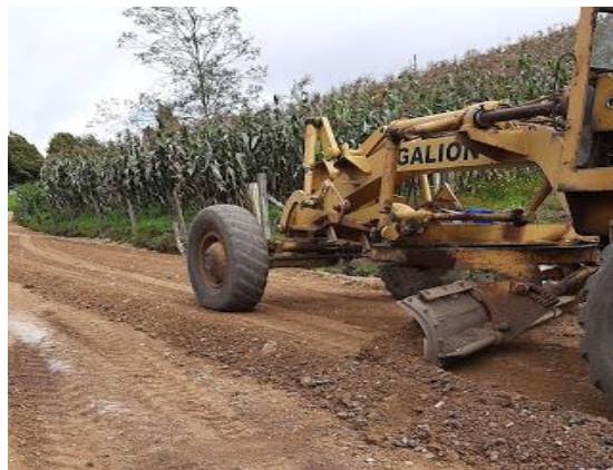
Ilustración 3 Extendida subbase
