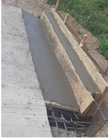
Ilustración 40 Fundida de Cuneta y bordillo
