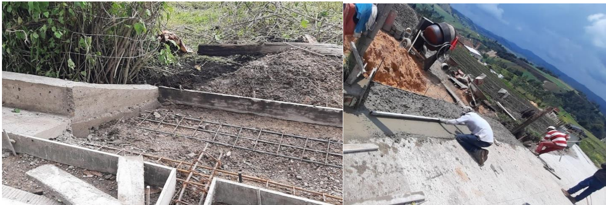
Ilustración 41 Acero de Refuerzo y Fundida de entradas
