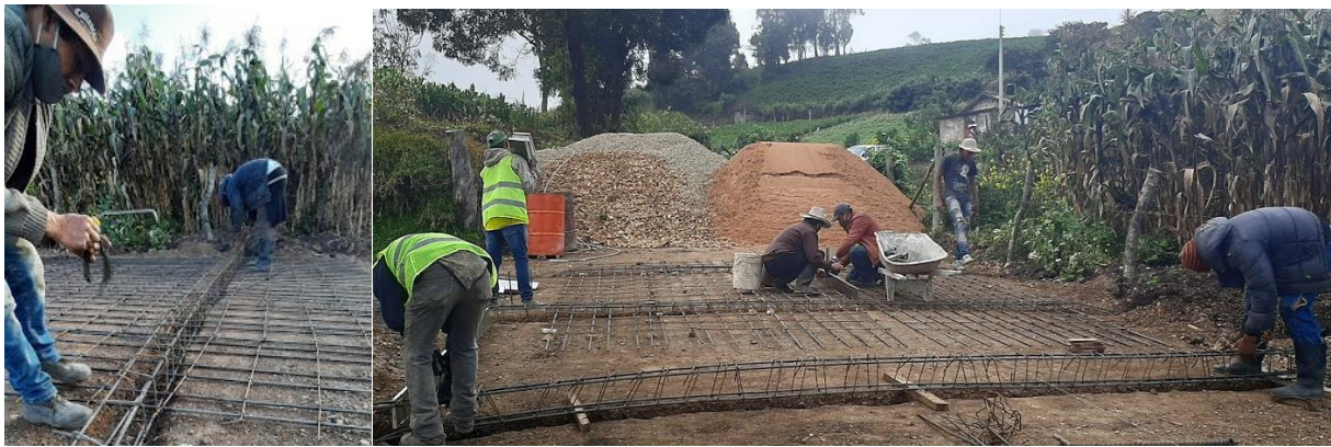
Ilustración 28 Amarrado Acero de refuerzo
