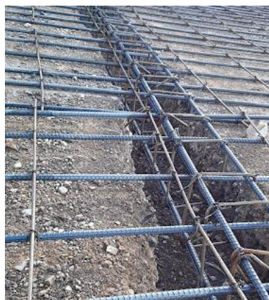
Ilustración 27 Acero de Refuerzo
