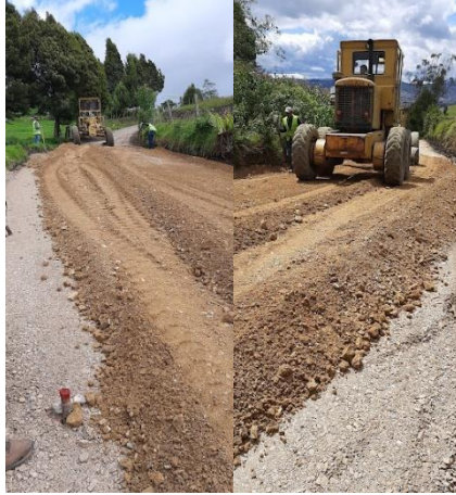
Ilustración 9 Extendida de Material de Subbase
