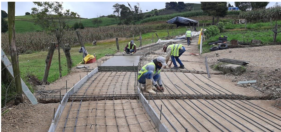
Ilustración 32 Fundida de Placas
