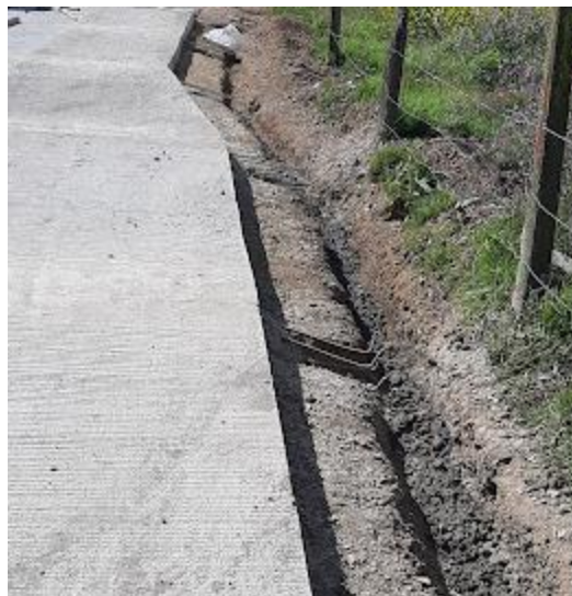
Ilustración 37 Excavación Cuneta y bordillo
