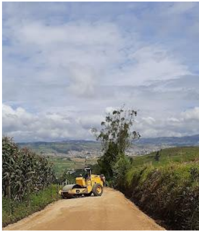
Ilustración 10 Compactación del terreno
