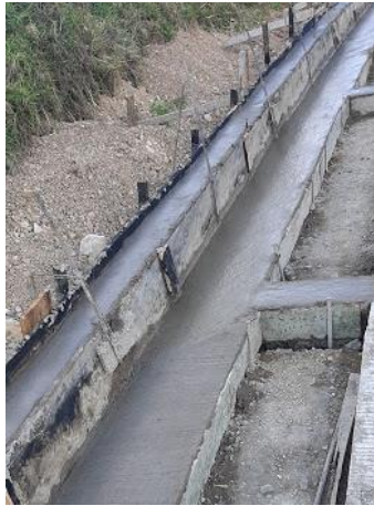
Ilustración 7 Cuneta y bordillo
