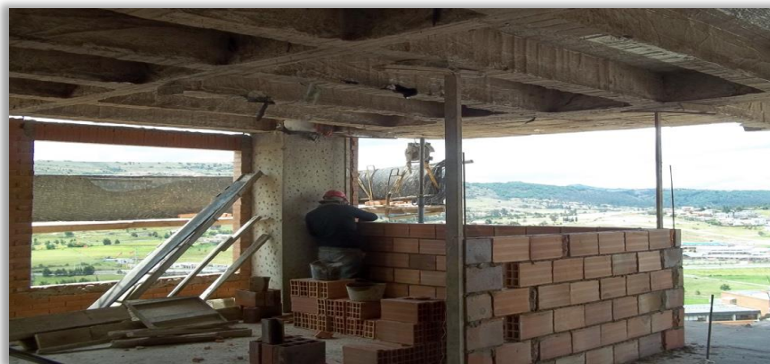
IMAGEN 7. Levante de muros.
