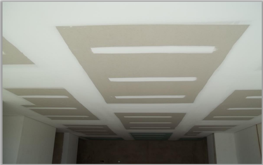
IMAGEN 12. Masillado en uniones de láminas
