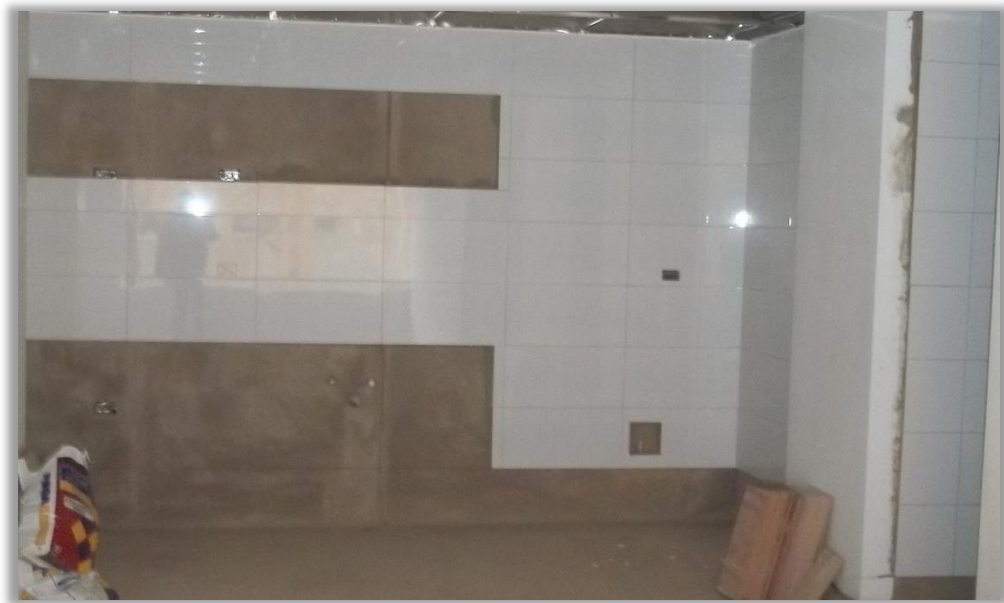
IMAGEN 11. Enchape en cocina
