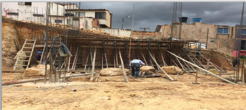
IMAGEN 4. Cimentación y muros de contención, zona comercial
