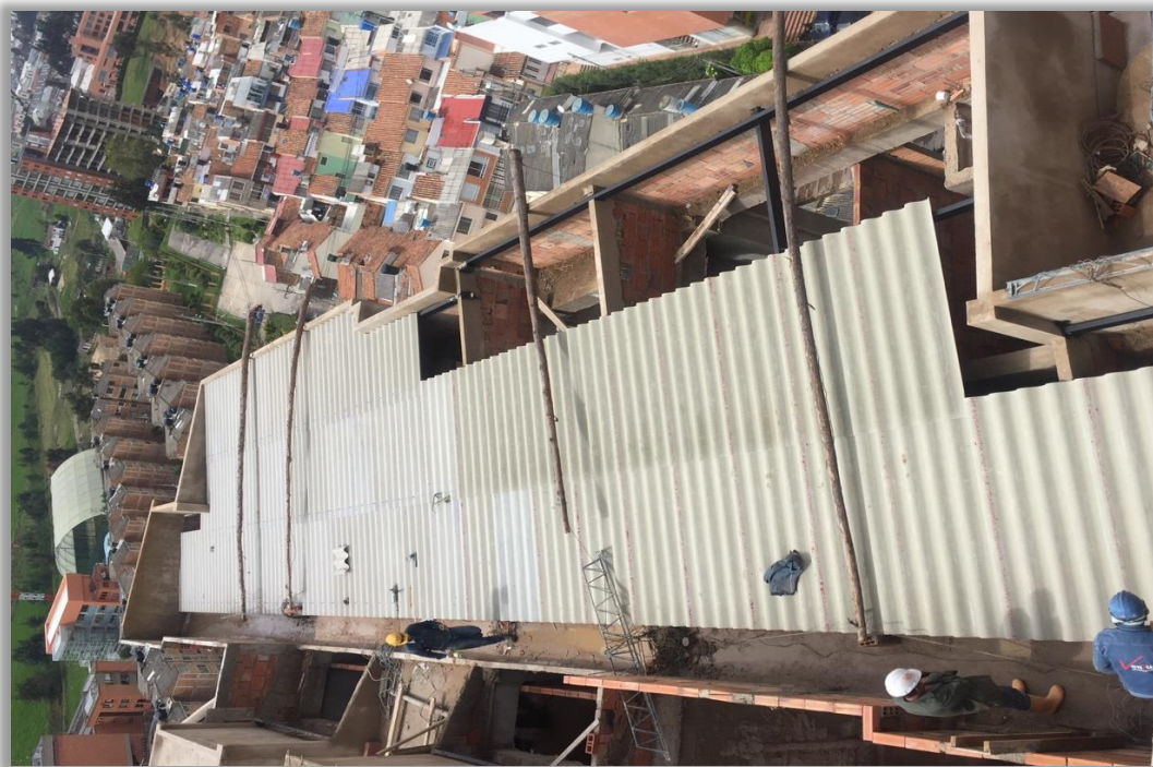
IMAGEN 9. Cubierta torre B2, instalación de teja en fibra-cemento.
