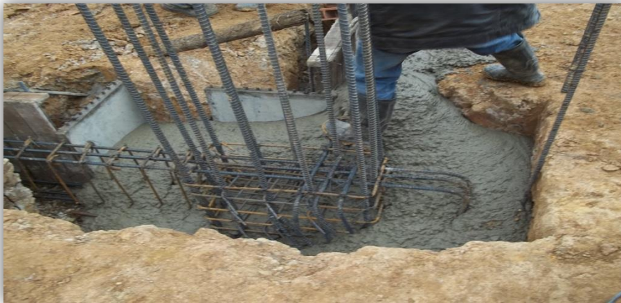
IMAGEN 6. Cimentación y vaciado de concreto
