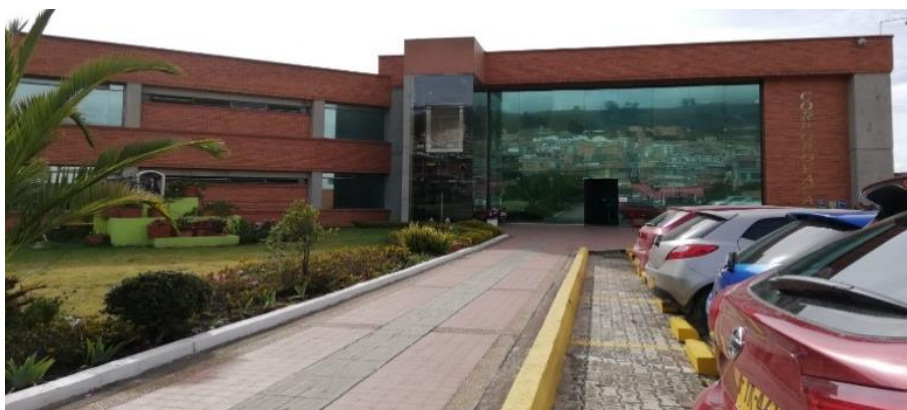
Figura 2. Instalaciones de la Corporación
