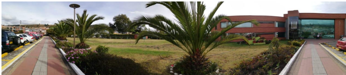
Figura 1. Sede principal de Corpoboyacá
