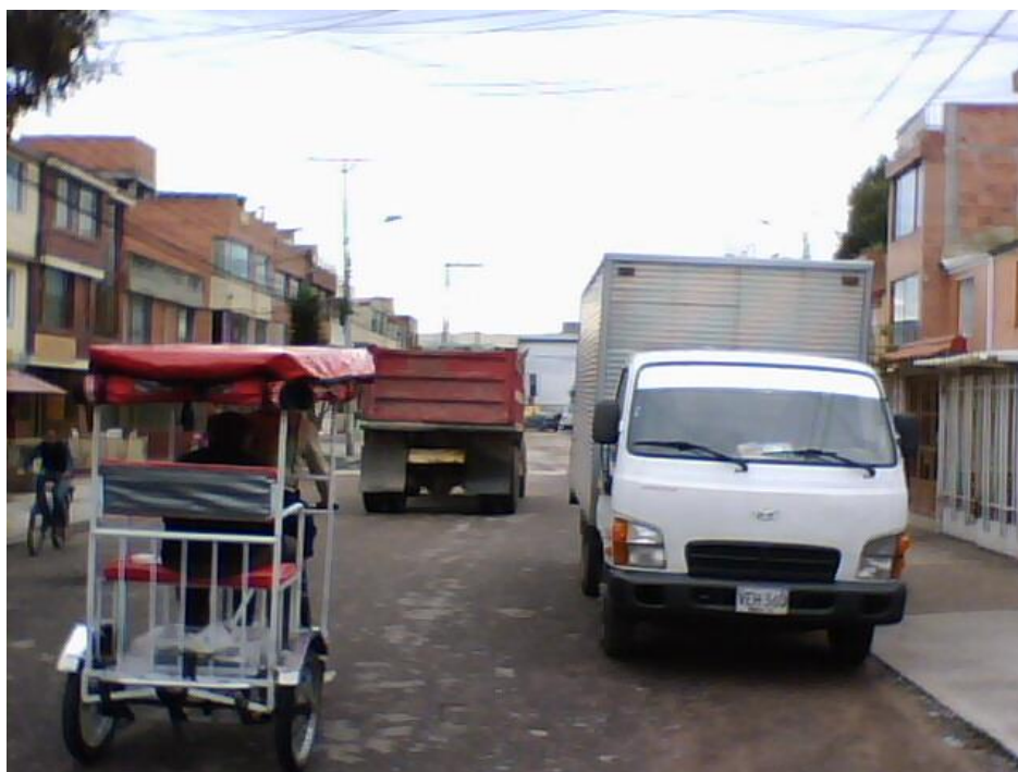
Figura 22. Pérdida de Agregado (PA), Cabezas Duras (CD) y Ondulaciones (OND). Severidad: Alta.
