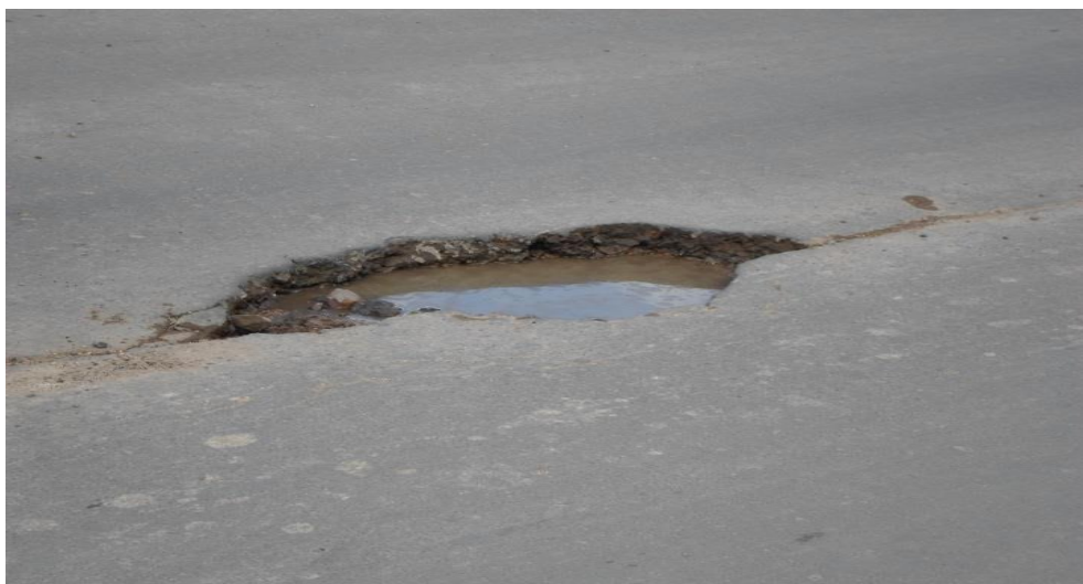
Figura 26. Bache (BCH). Severidad: Alta.
