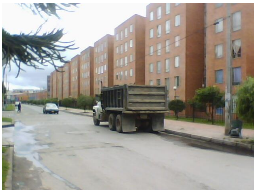
Figura 23. Fisuras en Juntas de Construcción (FCL), Fisuras Transversales (FT) y Pérdida del Agregado (PA). Severidad: Media.
