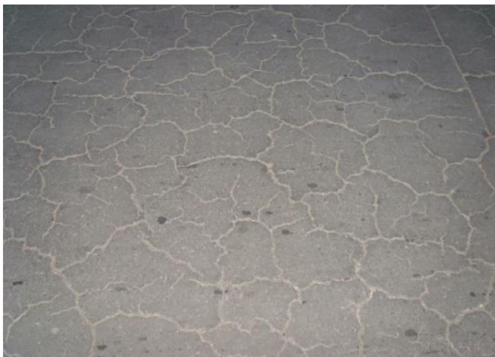
Figura 34. Piel de Cocodrilo (PC). Severidad: Media.
