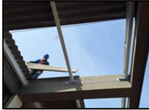
Figura 58. Desmonte cubierta Café Madrid
