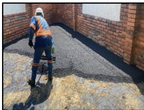
Figura 49. Aplicación mezcla densa en caliente Francisco de Paula Santander
