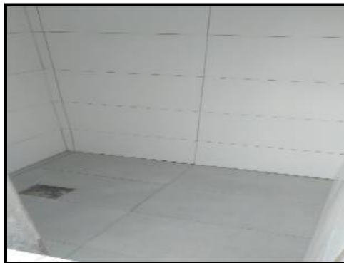
Figura 43. Enchape piso y pared baños piso 2 Club Unión
