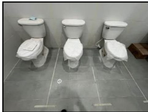
Figura 46. Instalación sanitarios Club Unión
