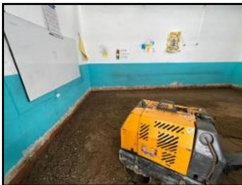
Figura 30. Aplicación base granular y compactación Salesiano
