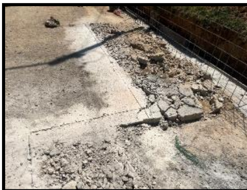
Figura 20. Demolición placa Rural Vijagual
