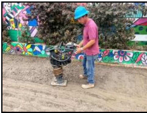
Figura 64. Aplicación base granular comuneros
