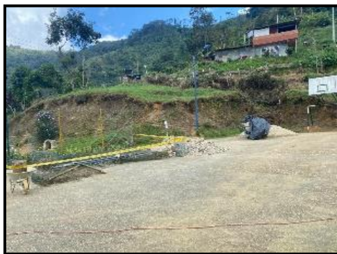
Figura 18. Desmonte de malla de cerramiento Rural Vijagual
