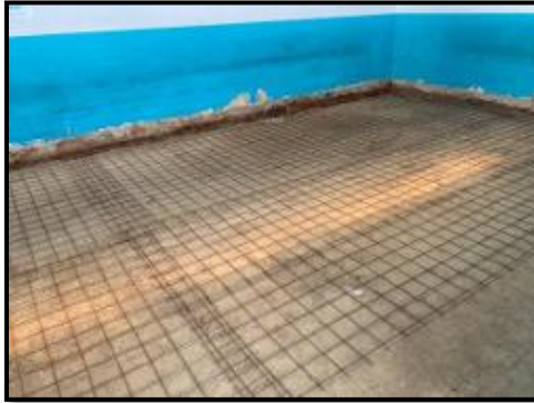
Figura 31. Instalación malla electrosoldada Salesiano
