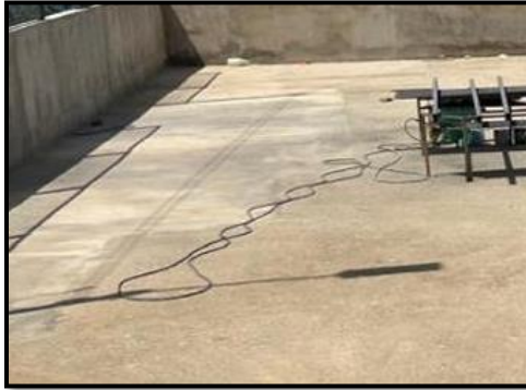
Figura 24. Fundición muro Rural Vijagual
