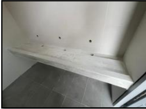
Figura 42. Mesón baños piso 1 Club Unión
