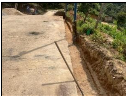
Figura 19. Excavación viga Rural Vijagual
