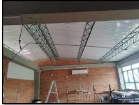
Figura 68. Desmonte salida y toma San Francisco de Asís
