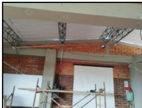
Figura 67. Desmonte luminaria San Francisco de Asís
