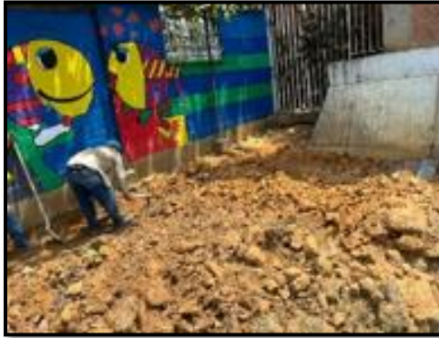
Figura 64. Aplicación base granular comuneros
