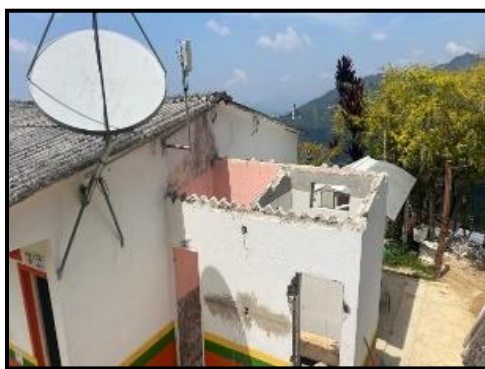
Figura 17. Desmonte de cubierta y sanitarios Rural Vijagual
