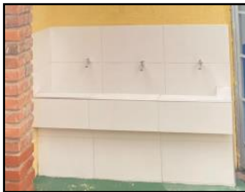
Figura 52. Instalación enchape Francisco de Paula Santander
