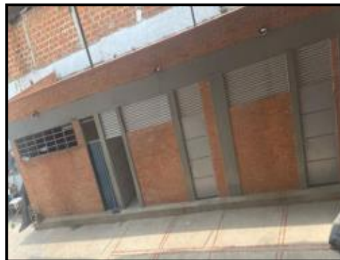
Figura 47. Instalación puertas y ventanas Club Unión
