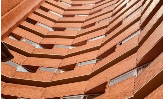
Figura 22. Detalle de fachada del edificio materialidad de ladrillo a la vista
