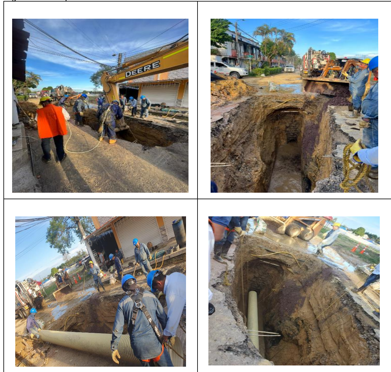
Figura 4. Reemplazo de tubería dañada en el barrio Castilla
