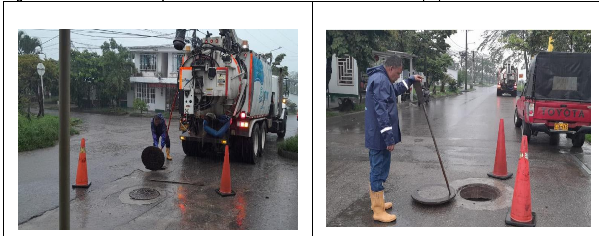
Figura 5. Labores de limpieza de sistema de alcantarillado con equipo de succión Vactor
