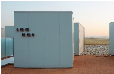
Figura 11. Estructura. Hotel Aire de Bardenas
