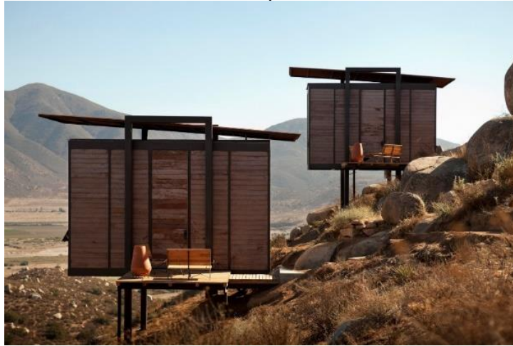
Figura 25. Estructura. Hotel Encuentro Guadalupe
