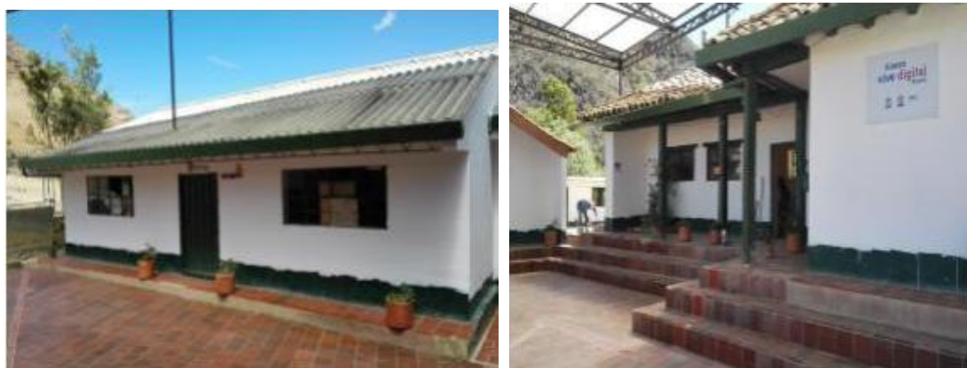
Fotografía No 22: Pintura tipo coraza para exteriores incluye resanes
