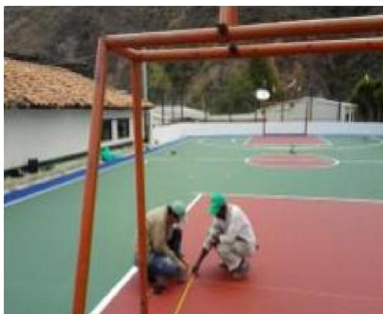
Fotografía No 19: Instalación piso sintético cancha múltiple según especificaciones técnicas (uni 8757)
