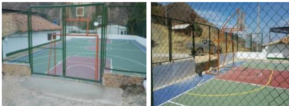
Fotografía No 26: Desmonte y montaje de malla eslabonada cancha sintética
