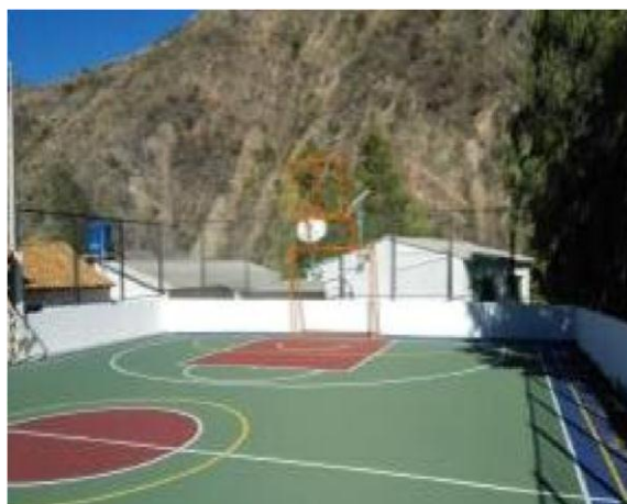
Fotografía No 19: Instalación piso sintético cancha múltiple según especificaciones técnicas (uni 8757)
