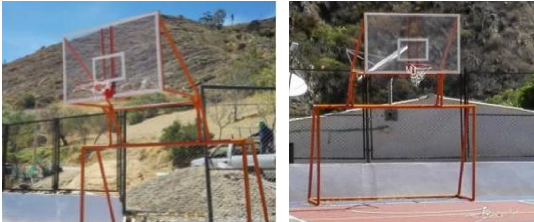
Fotografía No 23: Arreglo de tableros canchas y pintura
