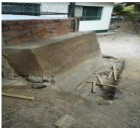
Fotografía No 21: Construcción de muro en concreto ciclopeo
