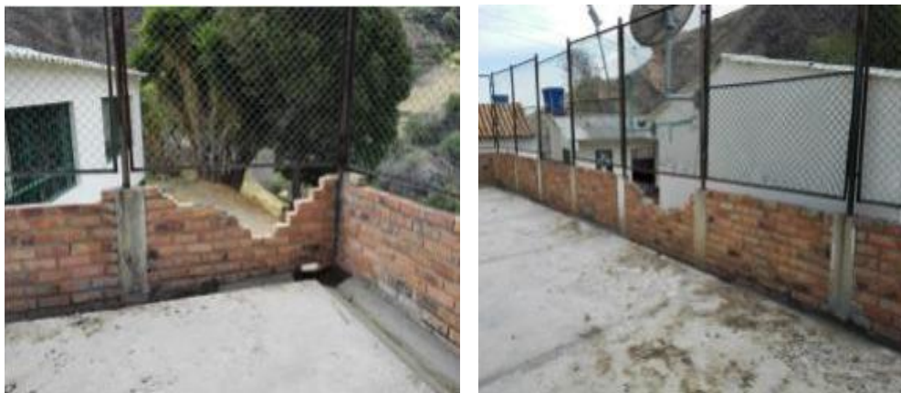
Fotografía No 24: Demolición y remplazo de muro tolete común e=0.12 m.
