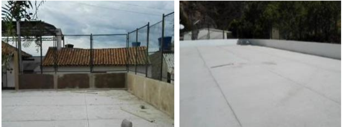
Fotografía No 25: Pañete mortero 1:4 imperm. muros (sede central)
