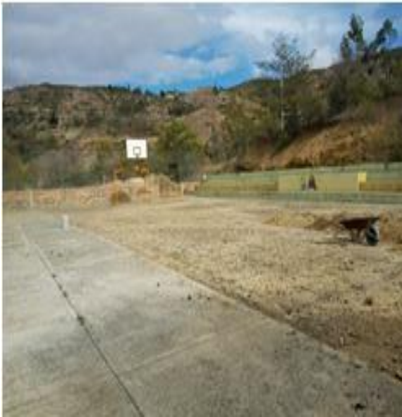
Fotografía No 29: Material de afirmado compactado
