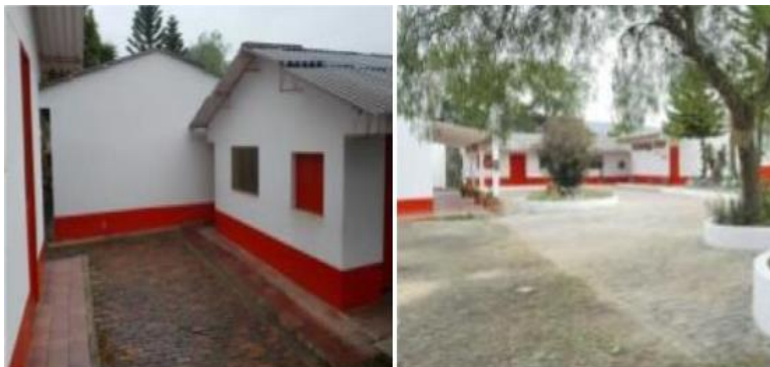
Fotografía No 12: Pintura tipo coraza para exteriores incluye resanes
