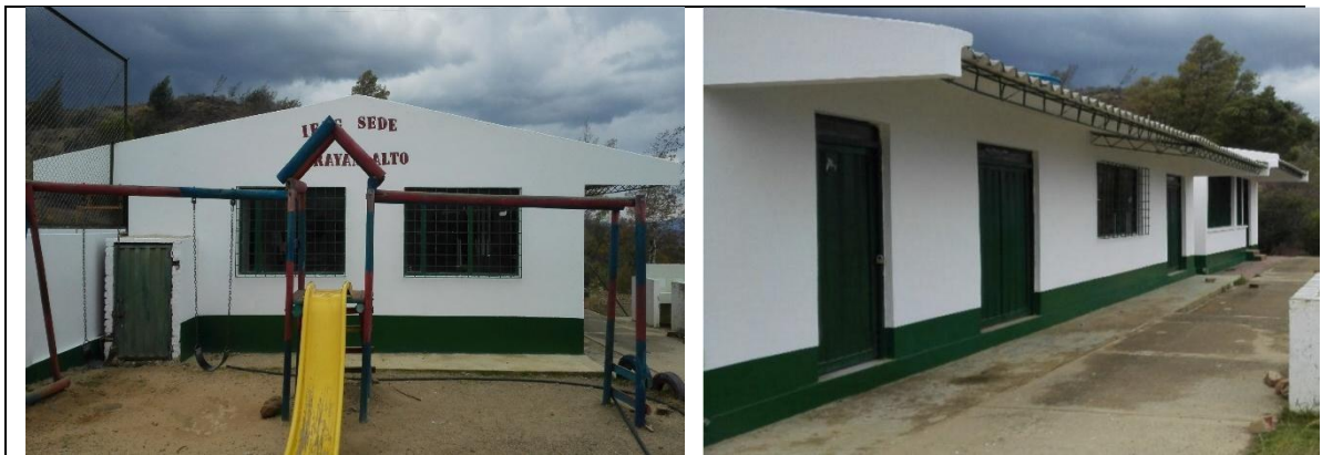
Fotografía No 32: Pintura tipo coraza para exteriores incluye resanes
