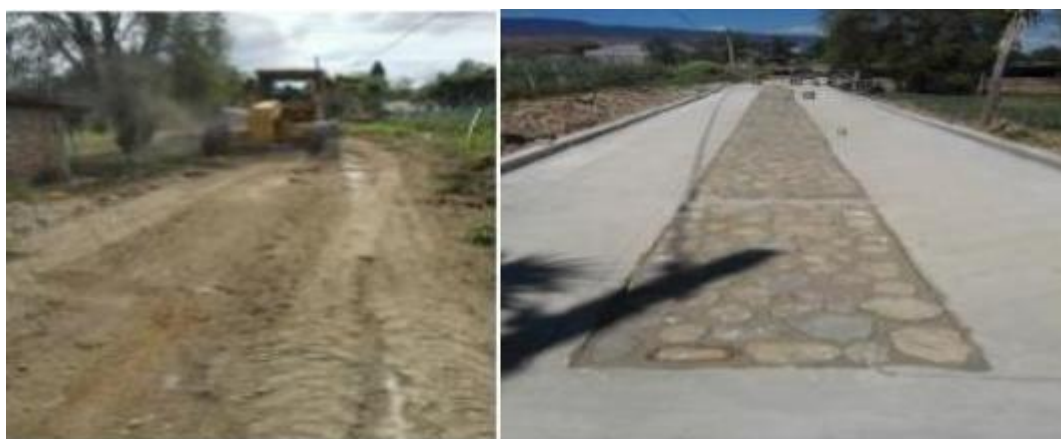
Fotografía No 15: Construcción de placa huella en concreto clase g y clase d.
