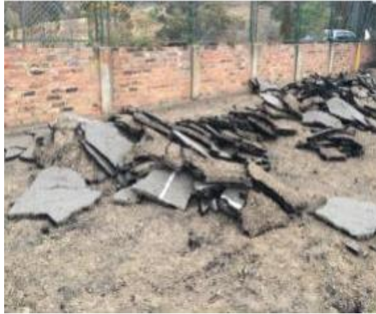
Fotografía No 16: Demolición pavimento asfáltico (incluye cargue y transporte hasta 5 km) \leq 10 cm
