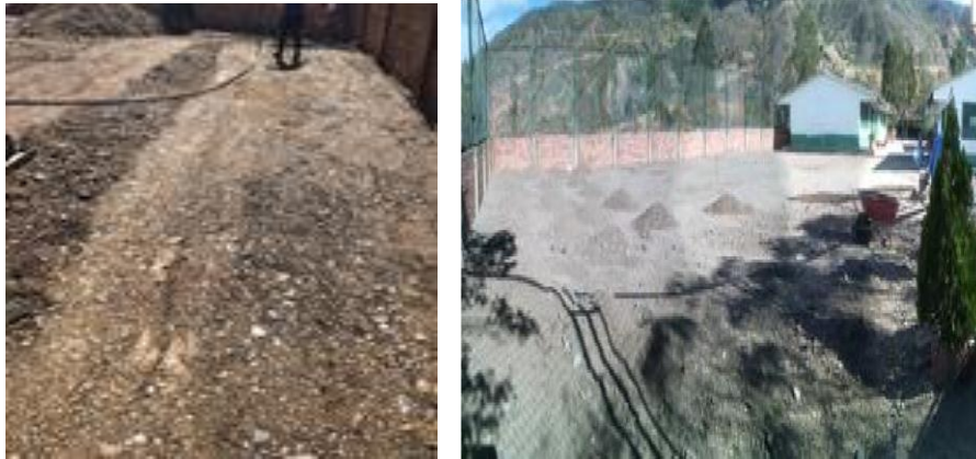
Fotografía No 38: Base en material de afirmado compactado
