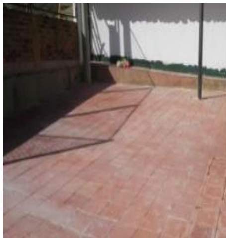
Fotografía No 20: Patio en concreto 2500 psi e=12 cm y tablón de gres 25*25 cm
