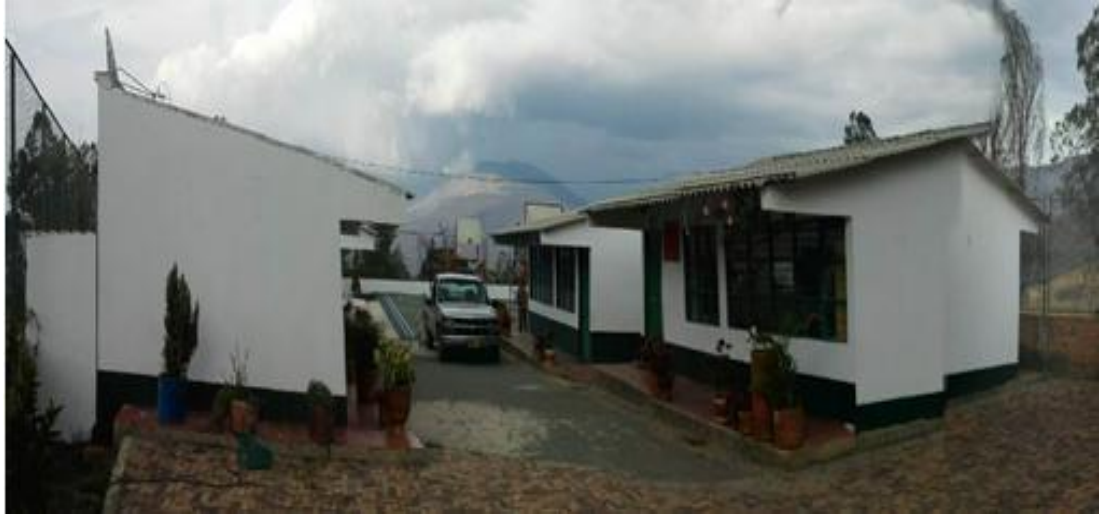
Fotografía No 43: Pintura tipo coraza para exteriores incluye resanes
