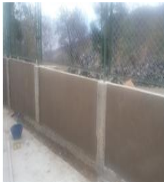
Fotografía No 34: Construcción de muros en ladrillo tolete común e=0.12 m. e instalación de pañete mortero 1:4 imperm. muros
