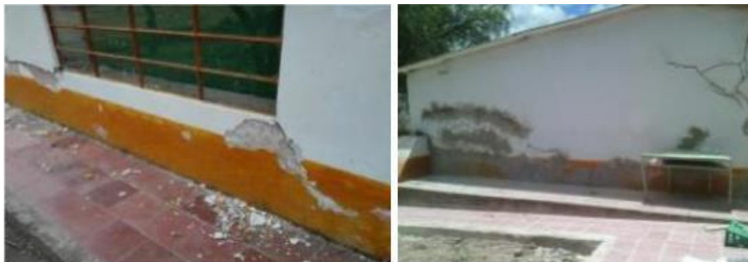
Fotografía No 14: Resanes en pañetes y grietas de muros
