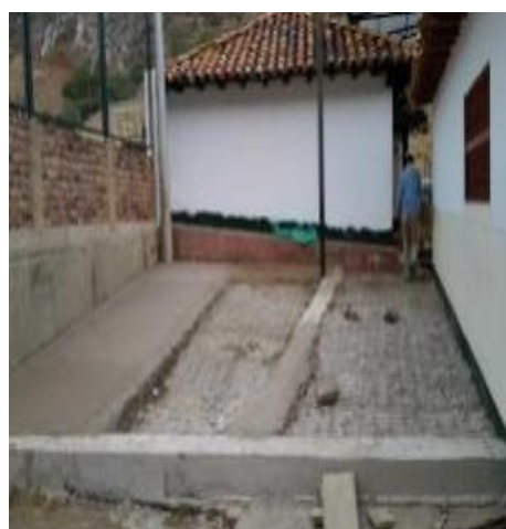
Fotografía No 20: Patio en concreto 2500 psi e=12 cm y tablón de gres 25*25 cm
