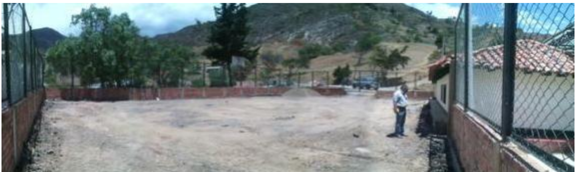
Fotografía No 17: Al de afirmado compactado
