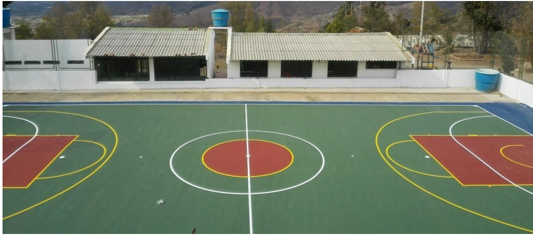
Fotografía No 31: Instalación piso sintético cancha múltiple
