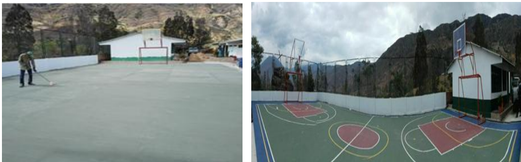
Fotografía No 40: Instalación Piso Sintético cancha Múltiple según Especificaciones Técnicas (UNI 8757)
