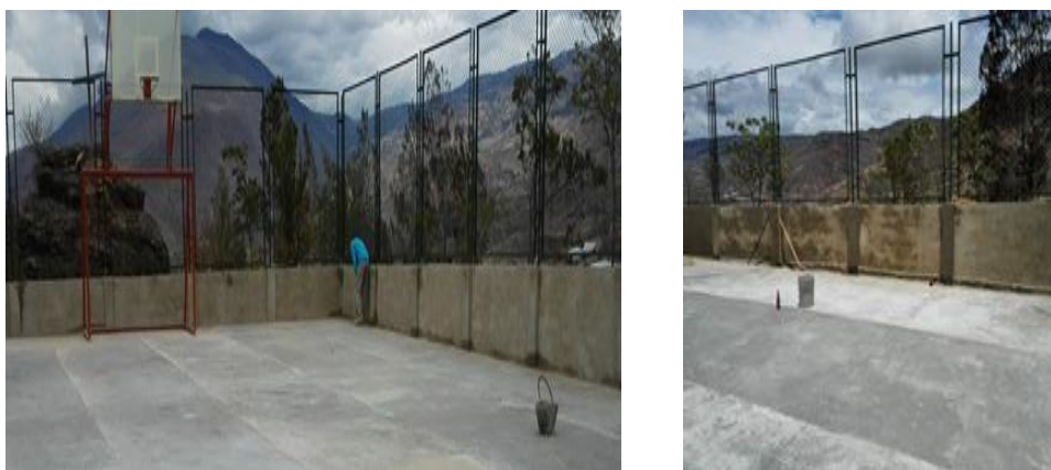
Fotografía No 41: Pañete mortero 1:4 imperm. muros (sede central) - filos en pañetes
