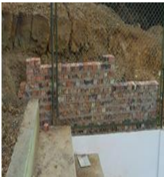
Fotografía No 34: Construcción de muros en ladrillo tolete común e=0.12 m. e instalación de pañete mortero 1:4 imperm. muros
