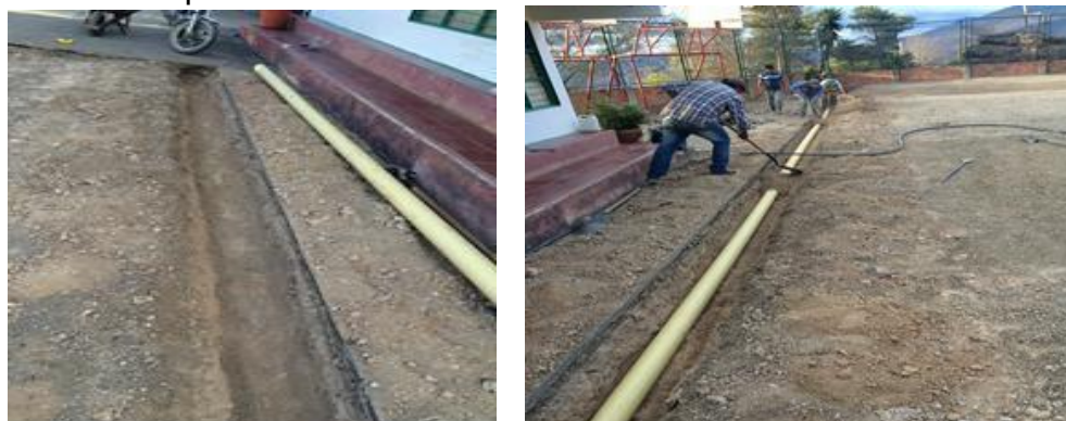
Fotografía No 42: Excavación manual y retiro material común - suministro e instalación tubería pvc
