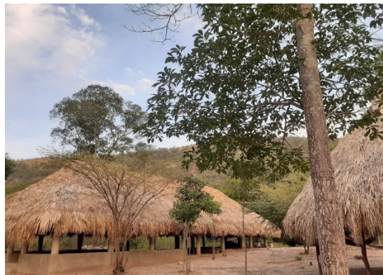
Imagen 18 Construcciones para alojamiento de voluntarios y visitantes.
