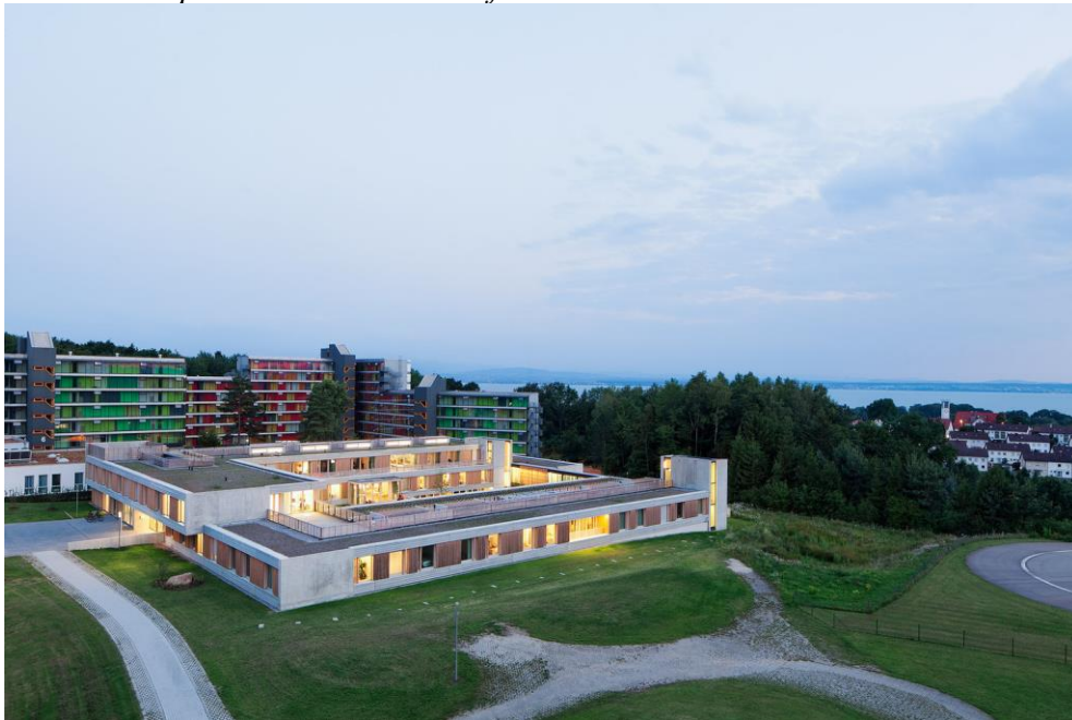
Figura 14. Centro Psiquiátrico Friedrichshafen.
